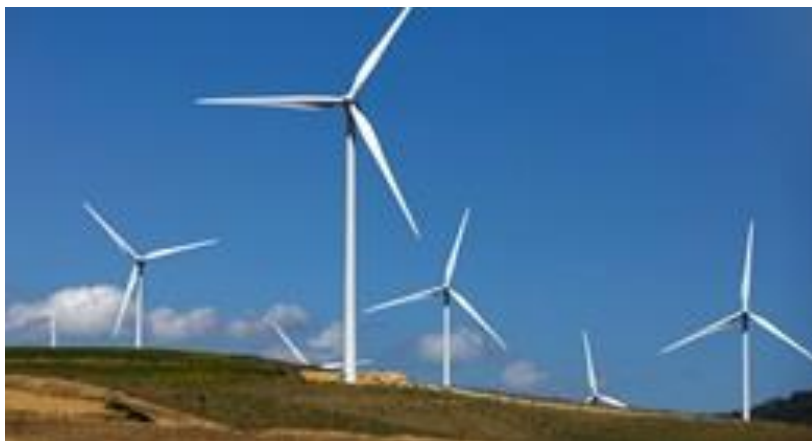
Kuva 7. Kahden megawatin tuuliturbiineita, joissa lavan pituus 49 metriä. Lähde: www.vestas.com
