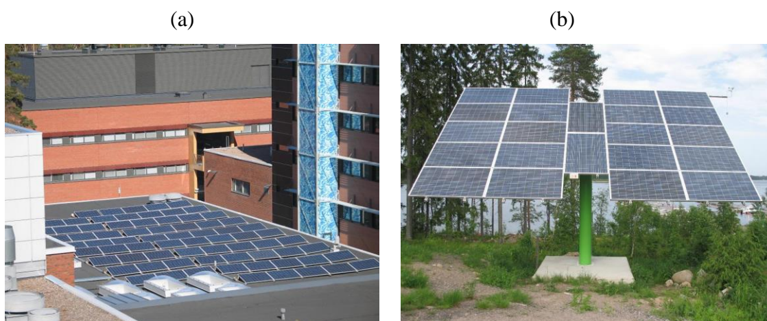
Kuva 5. (a) Kiinteä asennus LUT:n katolla. (b) Aurinkoa seuraava järjestelmä. Lähde: Tuuli- ja aurinkovoimateknologia ja liiketoiminta.
