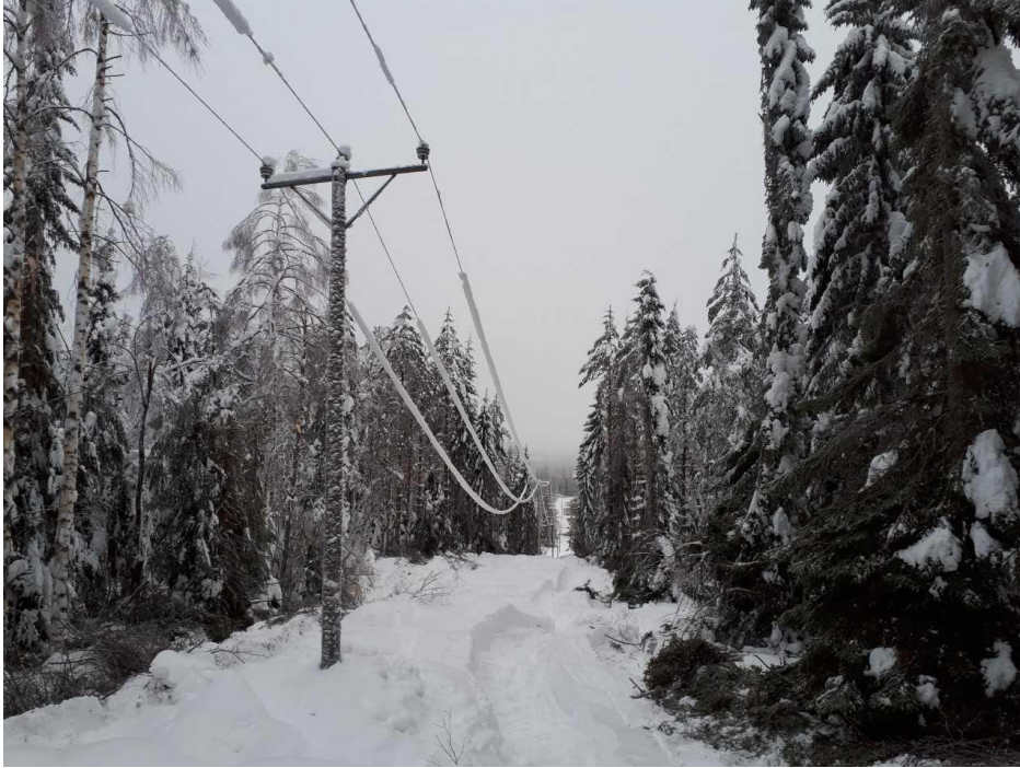
Kuva 3.4 Tykkylumen maata kohti painamia ilmajohtoja. Kuvassa näkyy myös vierimetsän puista karstittuja oksia (Tuovinen).
