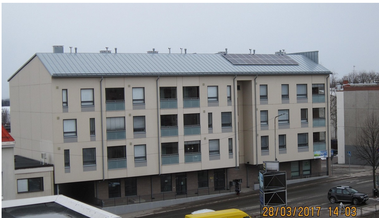
Kuva 3: Kuva tapauskohteesta, jossa aurinkopaneelit ovat katolla oikealla.
