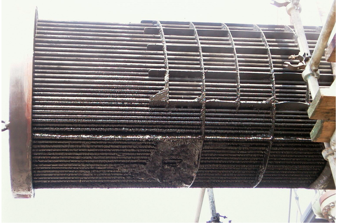
Kuva 18. Raakaöljyn esilämmityksen lämmönvaihtimen EA-10133 D tuubisarjat ennen vaihtimen puhdistusta kesällä 1999.
