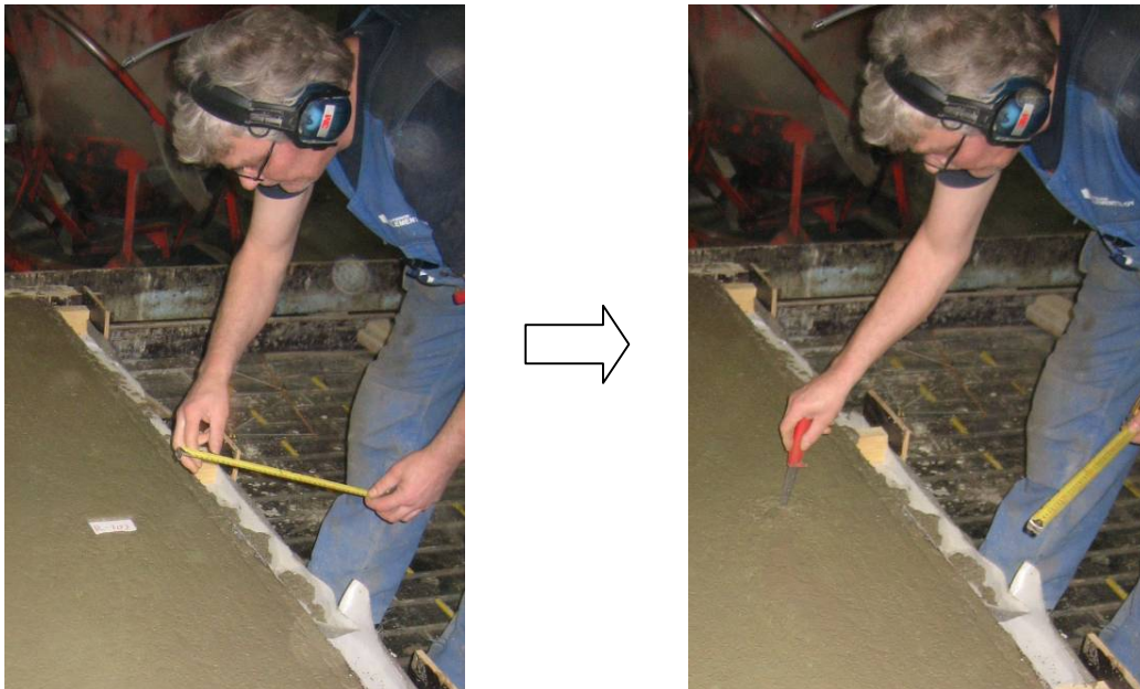
Kuva 10: Tunnisteeseen upottaminen märkään betoniin
