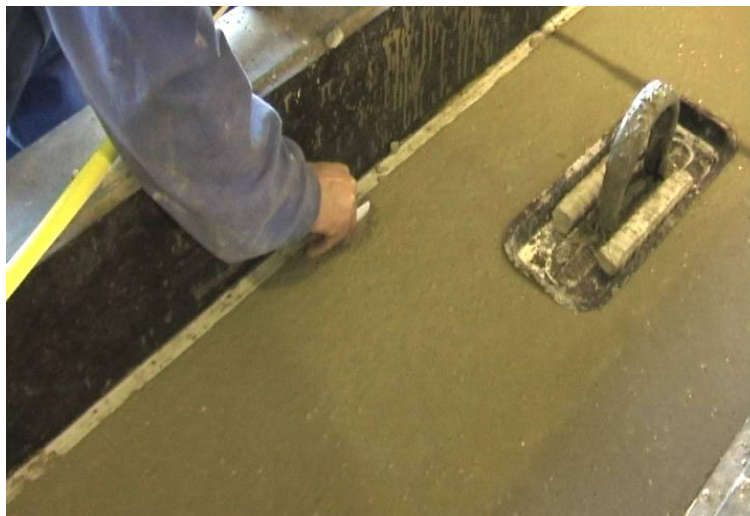
Kuva 6: Tunnisteiden upottaminen märkään betoniin
