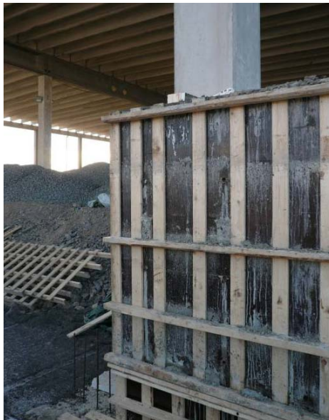
Kuva 8: Seinärakenne pilarin vieressä.
