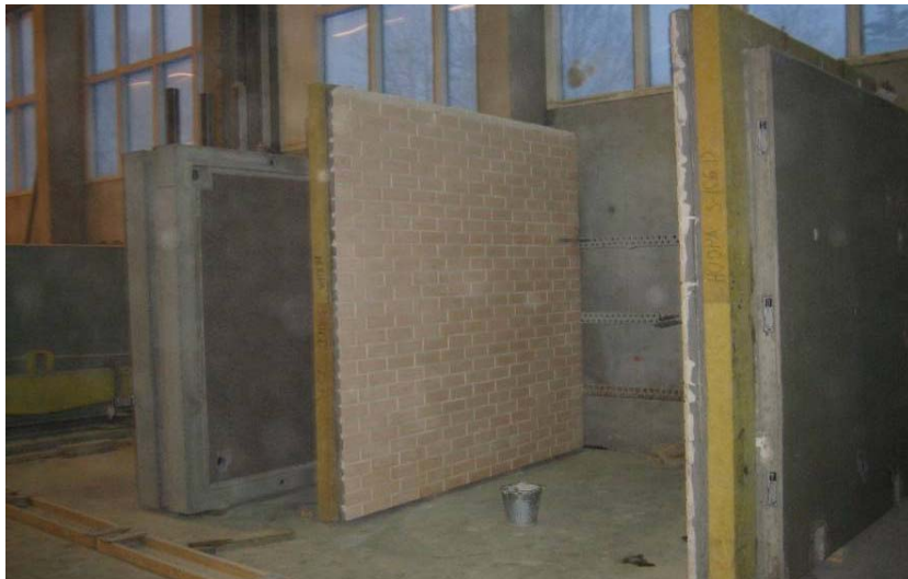
Kuva 11: Elementit telineisiin varastoituina
