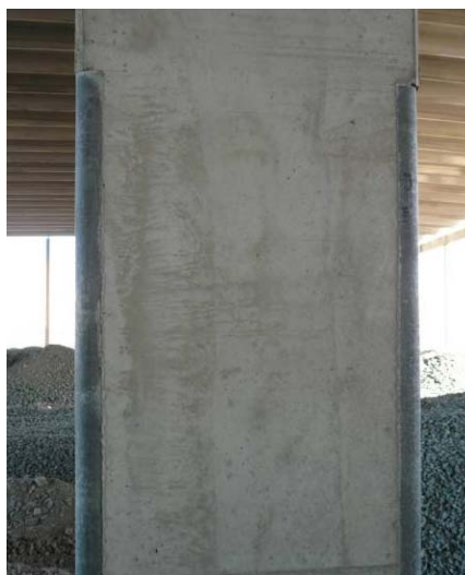
Kuva 7: Metallireunuksilla varustettu pilari
