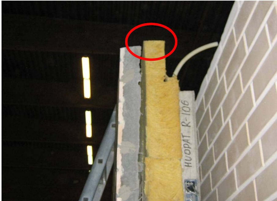
Kuva 17: Viiste elementin yläreunassa
