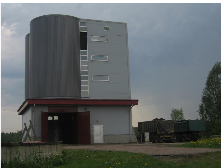
KUVA 2-7. LIETTEEN KUIVAUSRAKENNUS JA LIETESILOT. (Mäkikylän jätevedenpuhdistamo 2007.)
