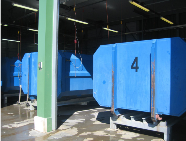
KUVA 2-6. LIETELAVOJA, JOILLE KUIVATTU LIETE JOHDETAAN JA JOILLA SE KULJETETAAN ETEENPÄIN. (Toikansuon jätevedenpuhdistamo 2007)
