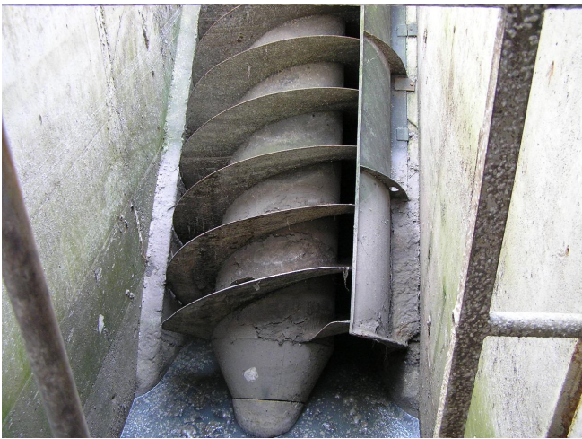
KUVA 2-5. SIIRTORUUVI PUHDISTUSPROSESSIN ALKUPÄÄSSÄ. (Nyyssönen, 29.5.2007).
