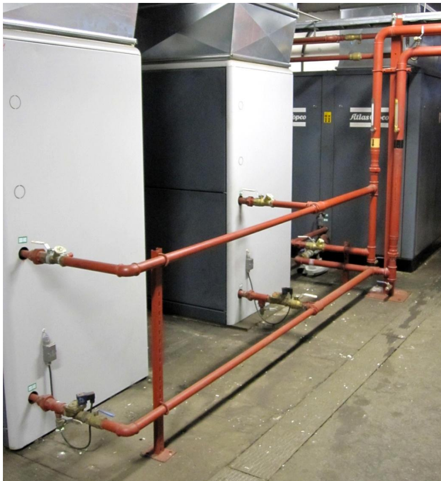
Kuva 5. Magneettiventtiilit ja virtauksensäätimet.
