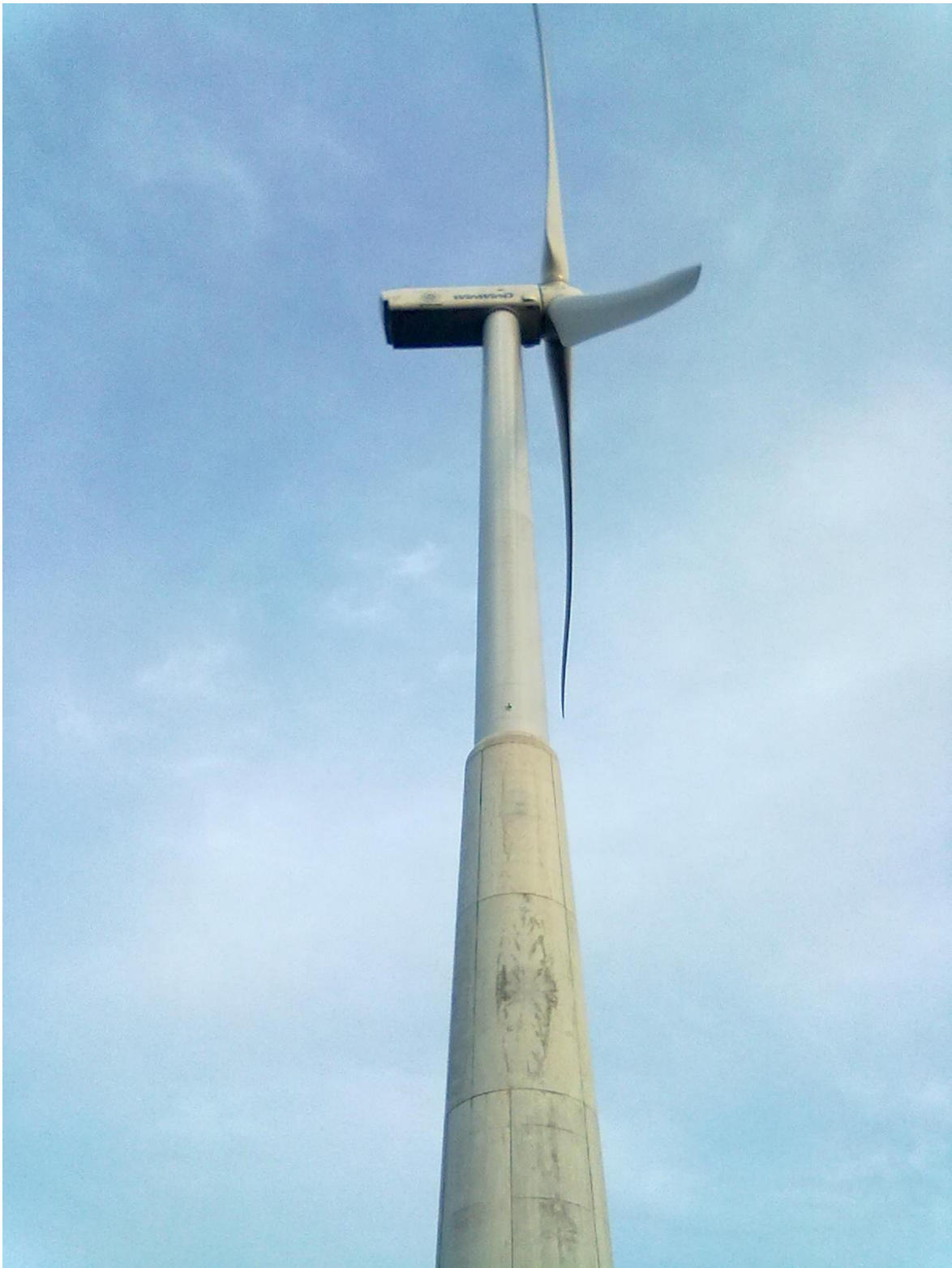
Kuva 1. Kolmen megawatin tuulivoimala Haminasta, Summan tuulipuistosta, turbiinin valmistaja WinWinD. (Kuva K. Helander)
