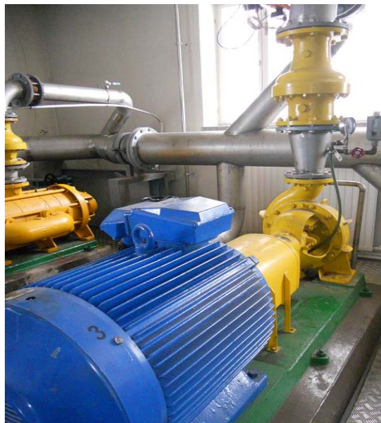
Kuva 3. Sähkökäyttöinen keskipakopumppu.
