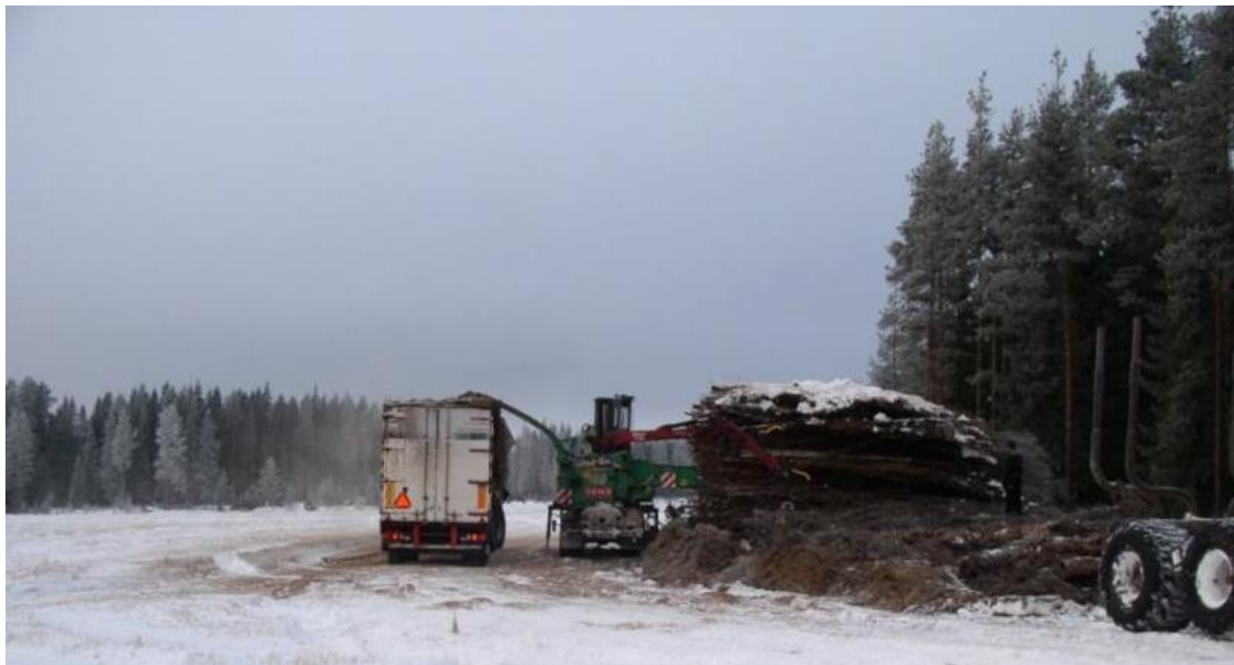
Kuva 14. Välivarastohaketusta hyvältä varastopaikalta (Lepistö 2011, 10).
