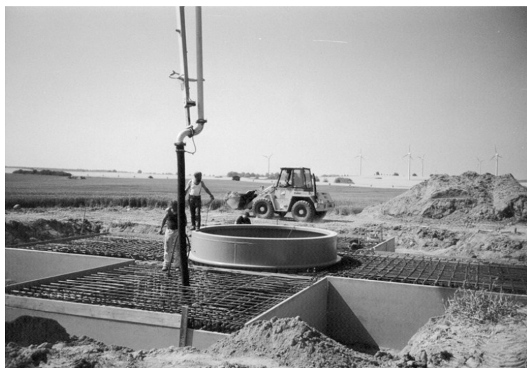
Kuva 5. Perustakappale asennettuna ennen perustan valutöitä.(Hau E. 2005, 445).
