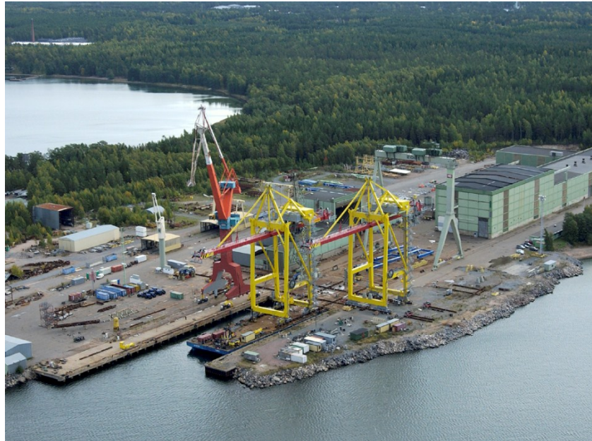
Kuva 1. Levatorin tehdasalue: käynnissä kahden konttinosturin lastaus
