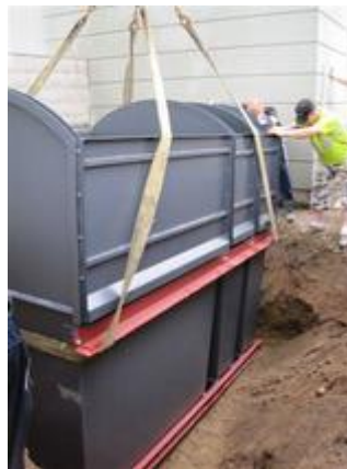
Kuva 16. Neliskanttinen syväkeräysastia teräsrakenteisella rungolla (Ecomp Oy).
