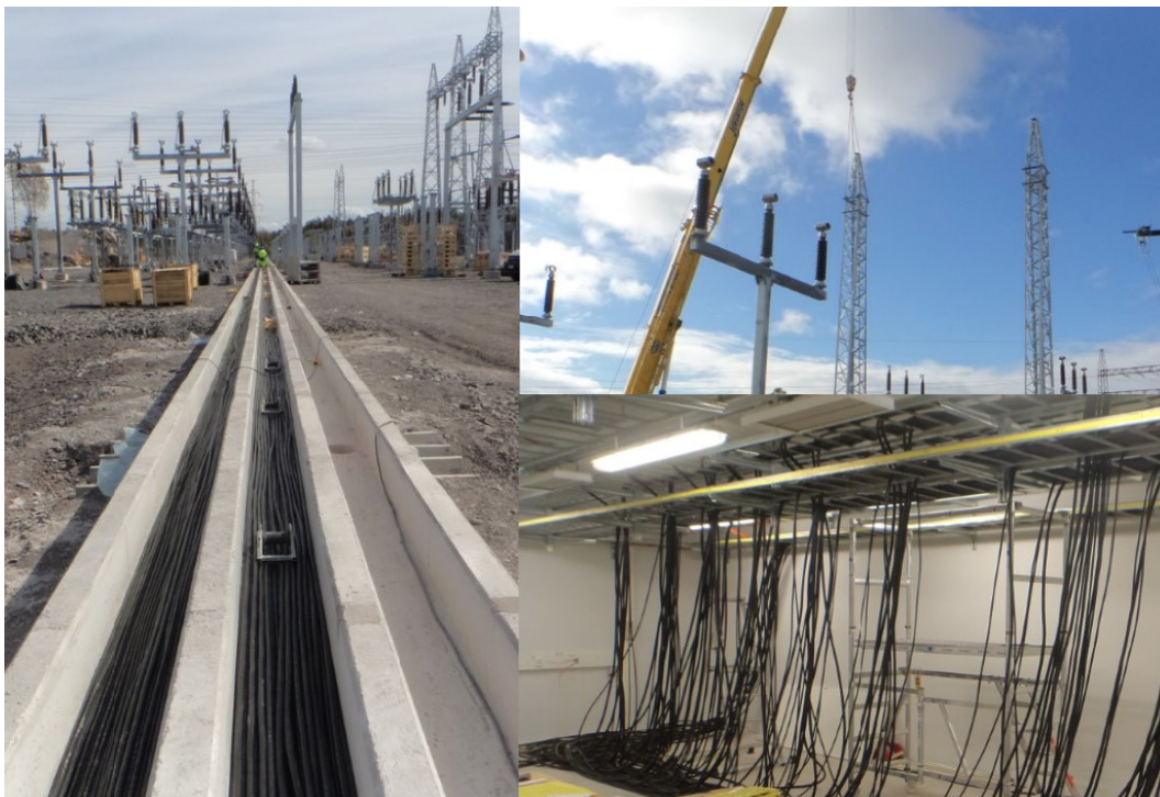
Kuva 4.4. Sähköaseman rakentamisen eri työvaiheita.
