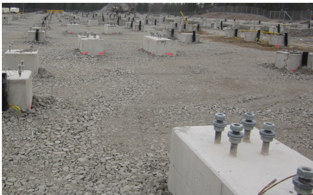
Kuva 4.3. Sähköaseman portaalien ja kojeistojen perustuksia valmiina ankkuripultteineen.
