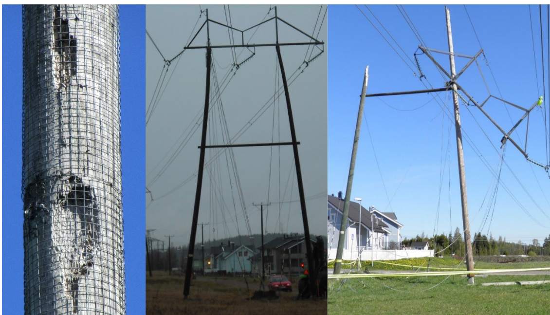
Kuva 2.3. Huonokuntoisia voimajohtopylväitä.
