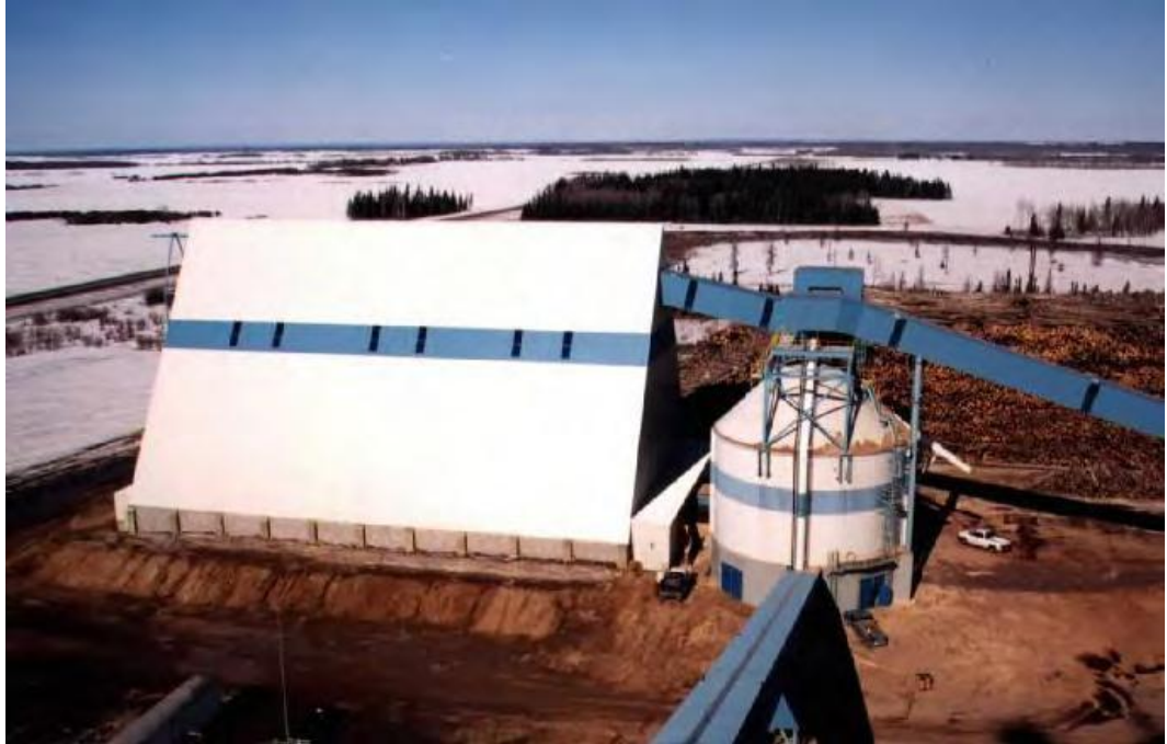
Kuva 24. A-pylväs siilo ja pyöreä siilo hakkeen ja kuoren varastointiin sellutehtaalla. (Lindberg et al., 2012)
