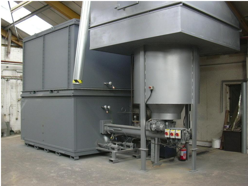
Kuva 15. Kattila kuvattuna polttoaineen syöttöpuolelta. (Pritchard 2005)
