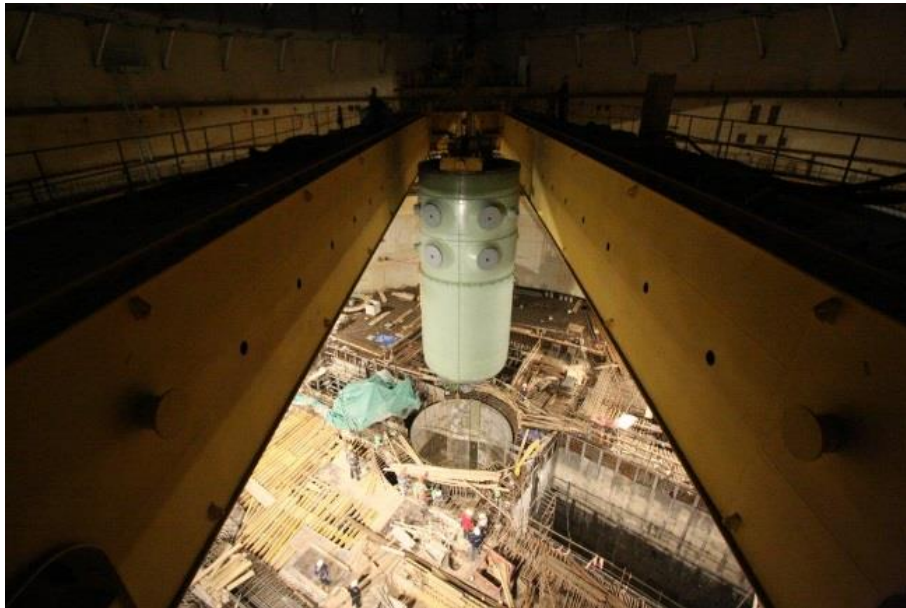
Kuva 7: VVER-1200 reaktorin painesäiliön nosto
