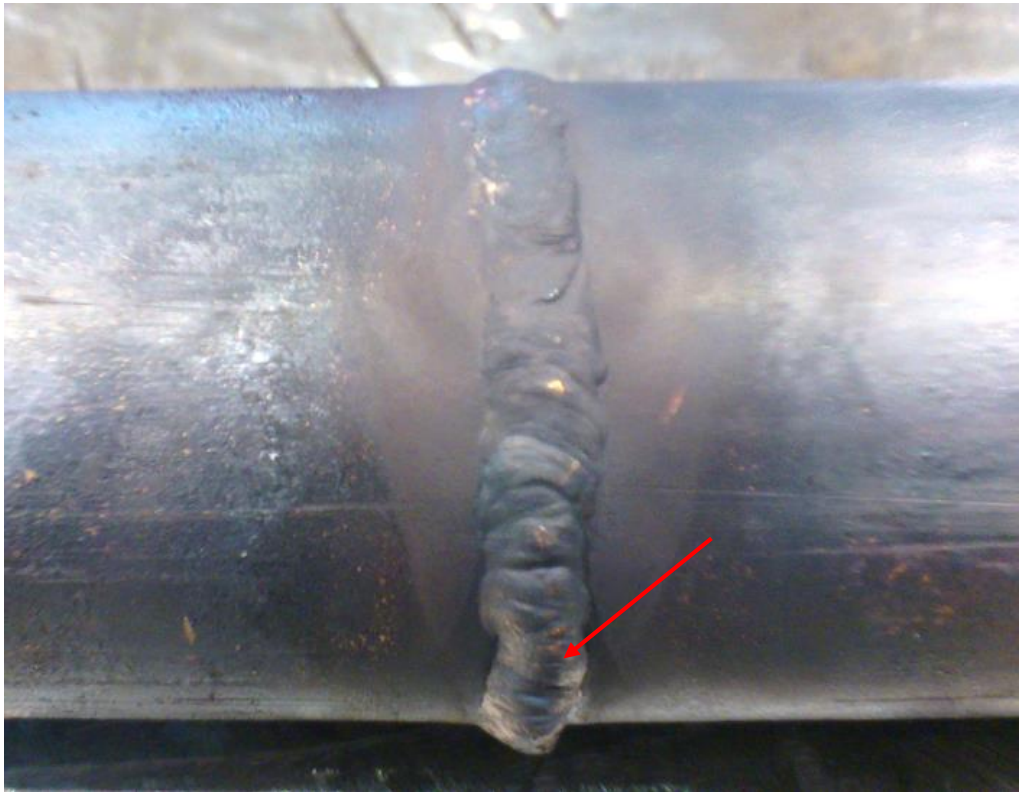
Kuva 28. Kuparikoekappale 5. Hitsissä on paikoittain korkeaa kupua.
