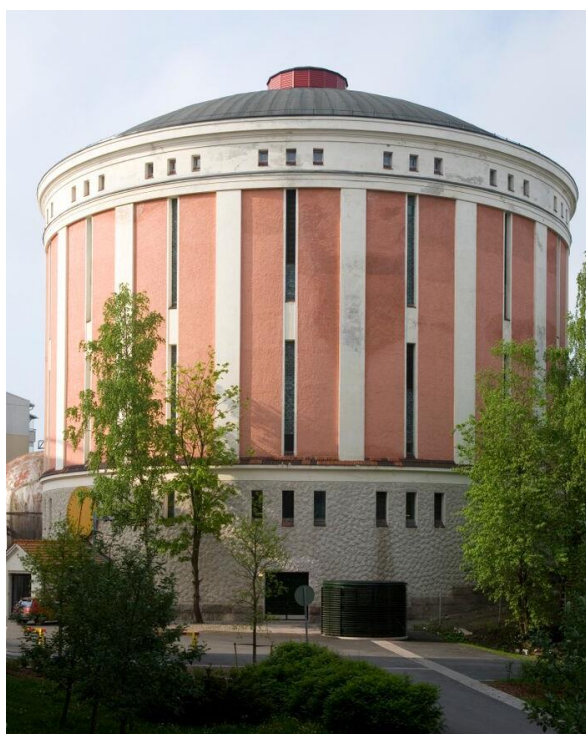
Kuva 11. Turun kaasukelloon sijoitettu lämpöakku. (Turku Energian kuva-arkistot.)
