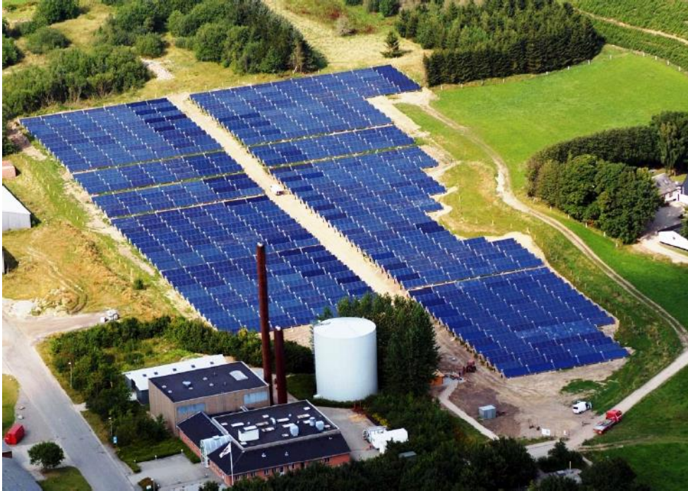
Kuva 8. Aurinkolämpöjärjestelmä yhdistettynä kaukolämpöön Brædstrupissa, Tanskassa. (CIT Energy Management AB 2010, 9)
