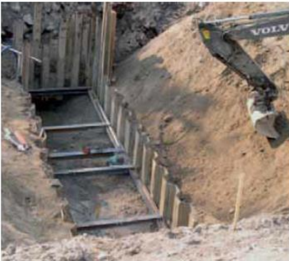
Kuva 30. Tuettu kaivanto (Suomen ympäristökeskus).
