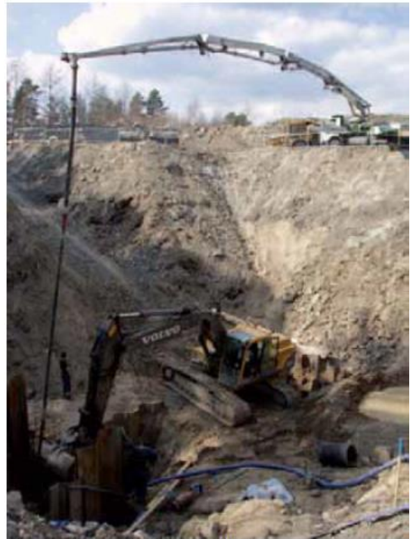
Kuva 31. Kallioperän injektointi (PIR).
