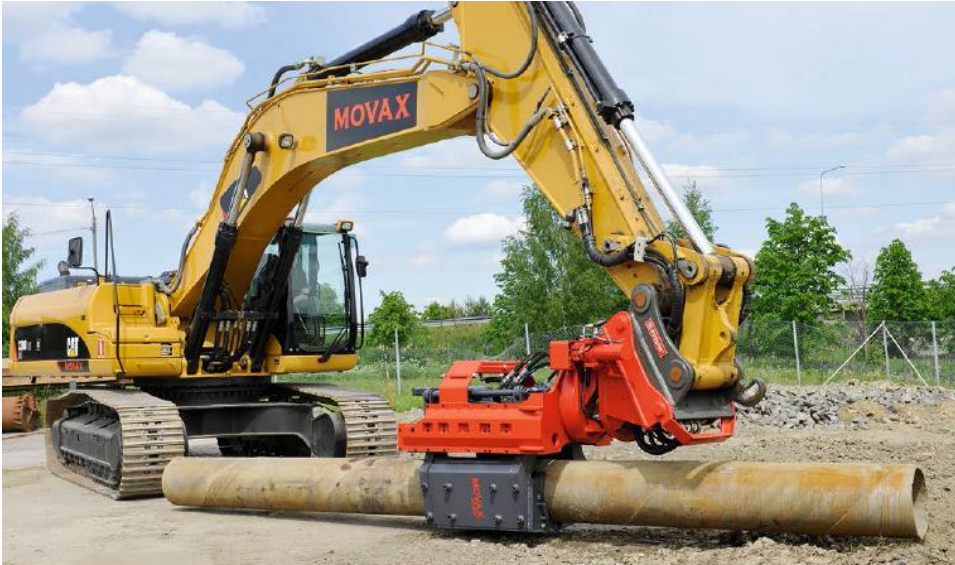
Kuva 16. Putkipaalun käsittelyä Movax SG -sarjan tuotteilla. (Movax Oy)
