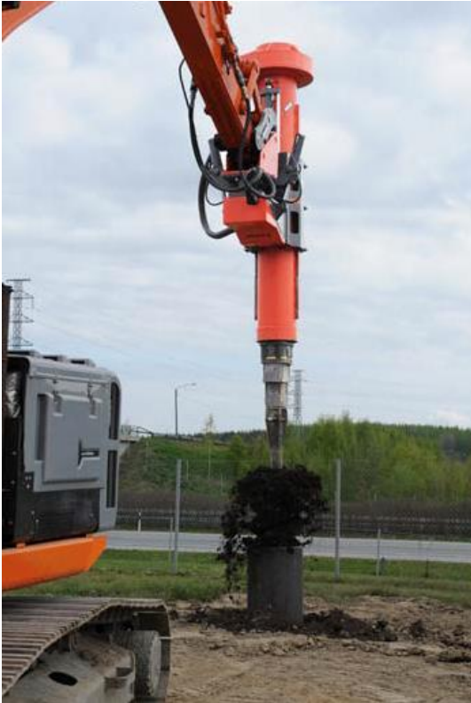
Kuva 18. Putkipaalun poraaminen maaporalla tyhjäksi. (Movax Oy)
