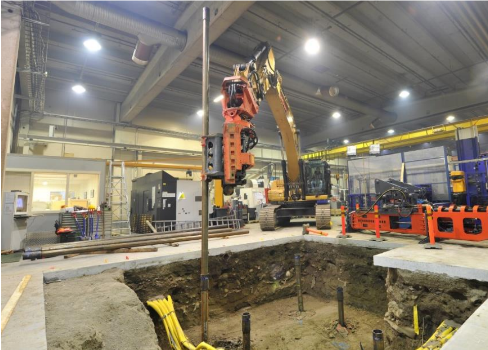
Kuva 14. Movaxin käyttö sisätiloissa. (Movax Oy)
