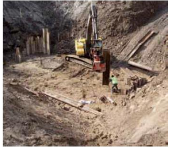
Kuva 29. Ponttiseinien tekoa (PIR).
