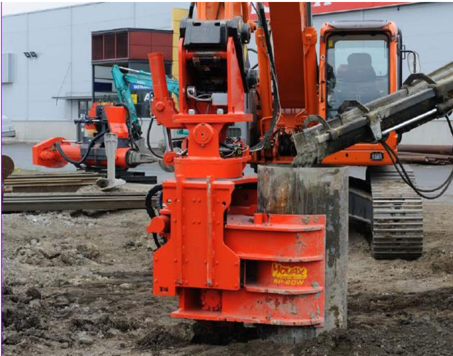
Kuva 19. Betonipilarin valua putkipaalun sisälle (Movax Oy)
