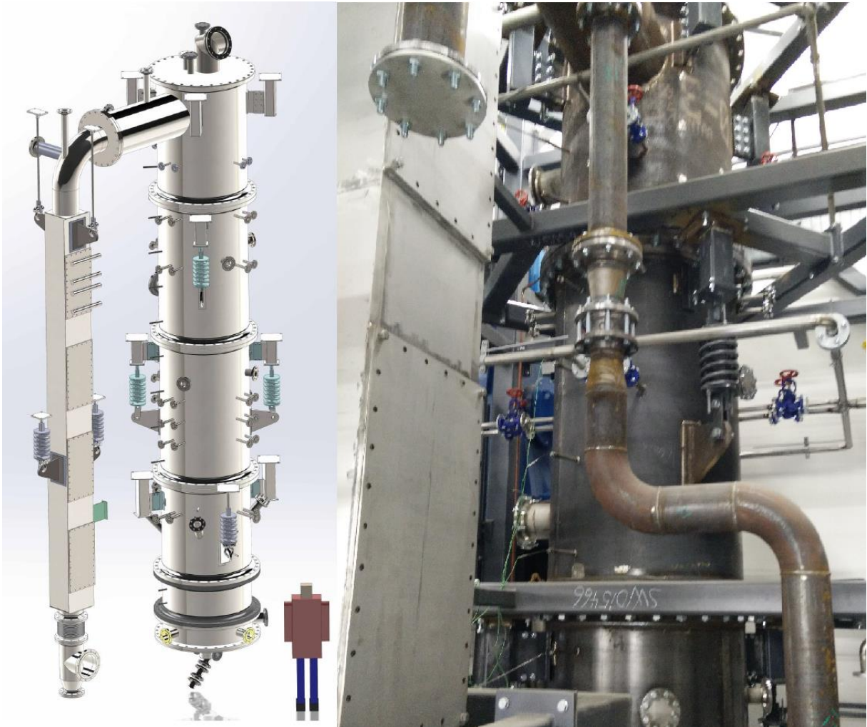
Kuva 3.1. Leijupetikattila teoriassa ja käytännössä. (Juutilainen 2015).
