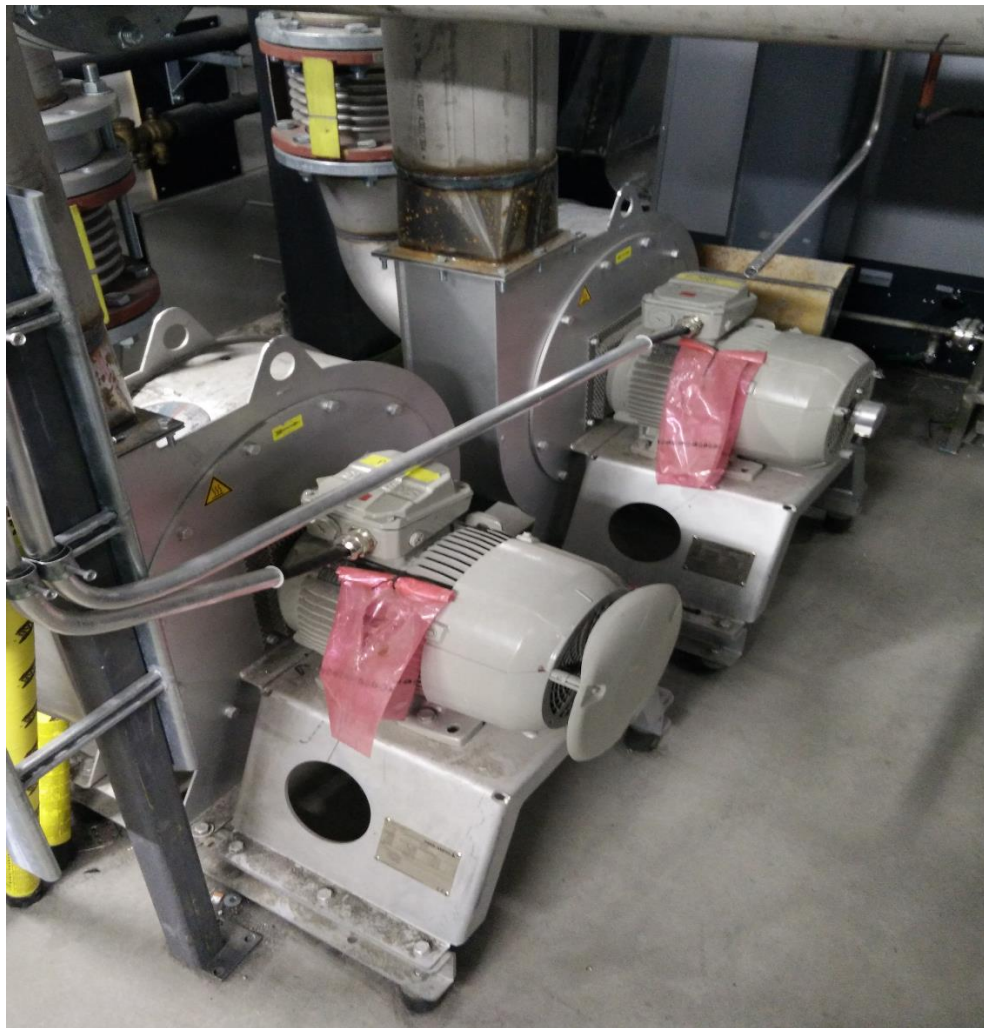
Kuva 3.2. Savukaasupuhaltimet P-3001 ja P-3002.
