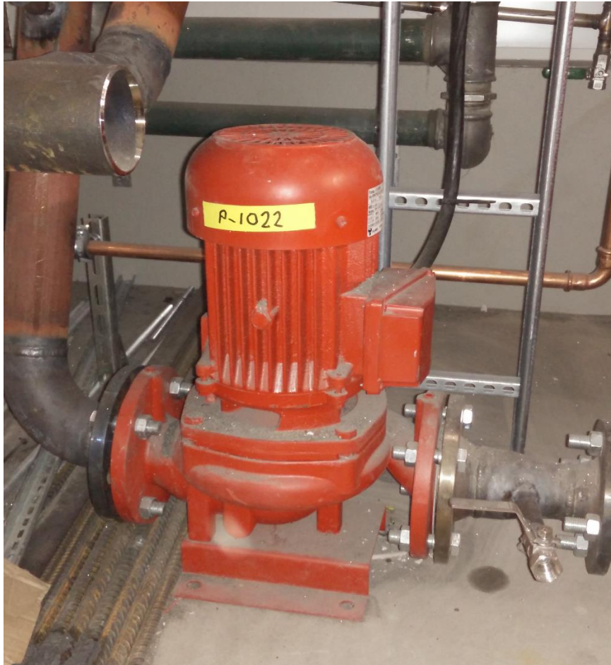
Kuva 3.3. Pumppu P-1022, työmaa kesken.
