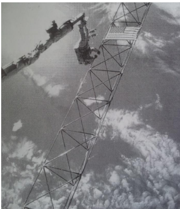
Kuva 3. Atlantis-avaruussukkulan ulkopuolella suoritettu kannatinrakenteen kokoaminen manuaalisesti vuonna 1985 (Paton et al. 1991, s. 491).
