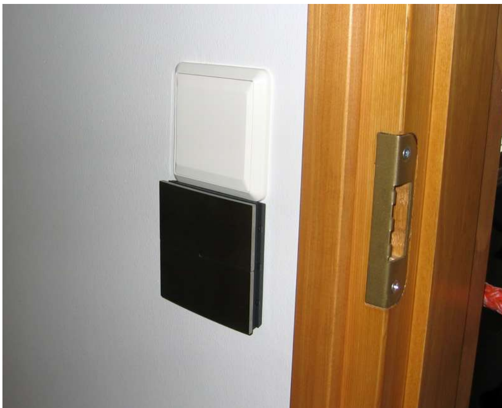
Kuva 24. Kun kodinohjausjärjestelmä (alempi koje) ei ole yhteensopiva asennuskalustesarjan (ylempi koje) kanssa, voi lopputuloksen ulkonäkö olla epäonnistunut. Kuva on messukohteesta Oulun asuntomessuilla vuonna 2005.
