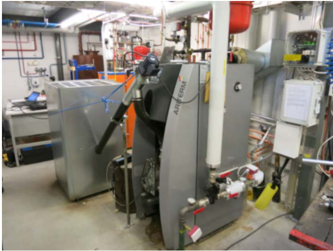
Kuva 16 Biomatic+ 20 -pellettikattila, joka sijaitsi Kaakkois-Suomen ammattikorkeakoulun LVI-laboratorion tiloissa.
