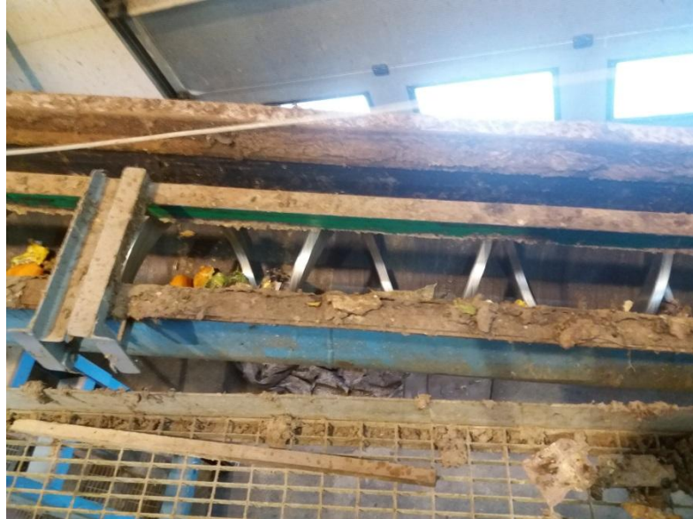
Kuva 13. Ruuvikuljettimella murskattua materiaalia siirretään separaattorille
