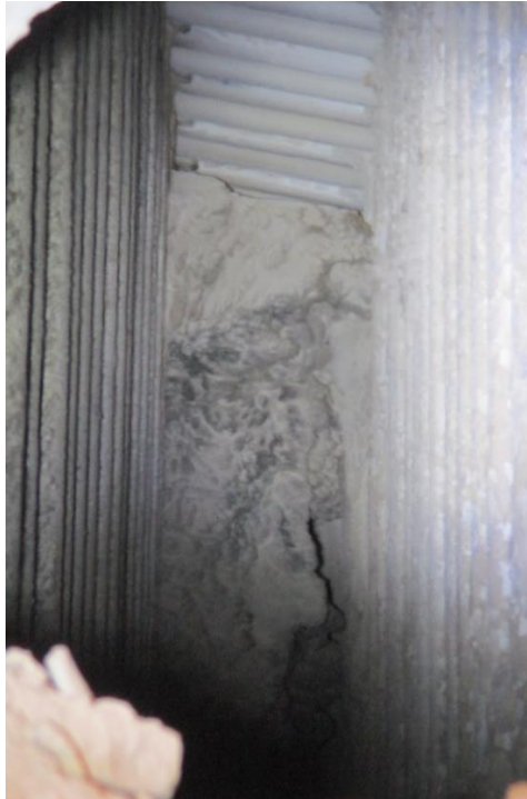
Kuva 29. Oikealta puolelta tukkeutunut tulistinalue (Kimmo Penttinen)
