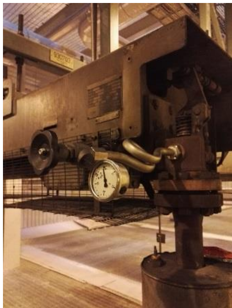
Kuva 72. Nuohoushöyryn paineen mittaus kulmaventtiililtä
