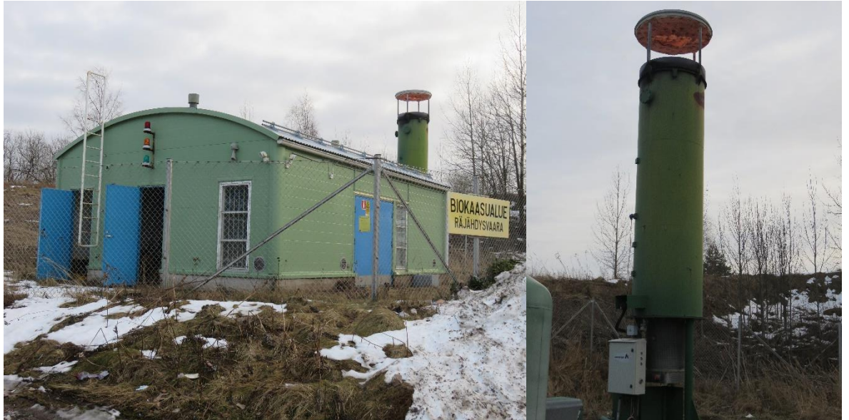
Kuva 2. Seutulampi kaatopaikan huoltorakennus ja soihutuspoltin.
