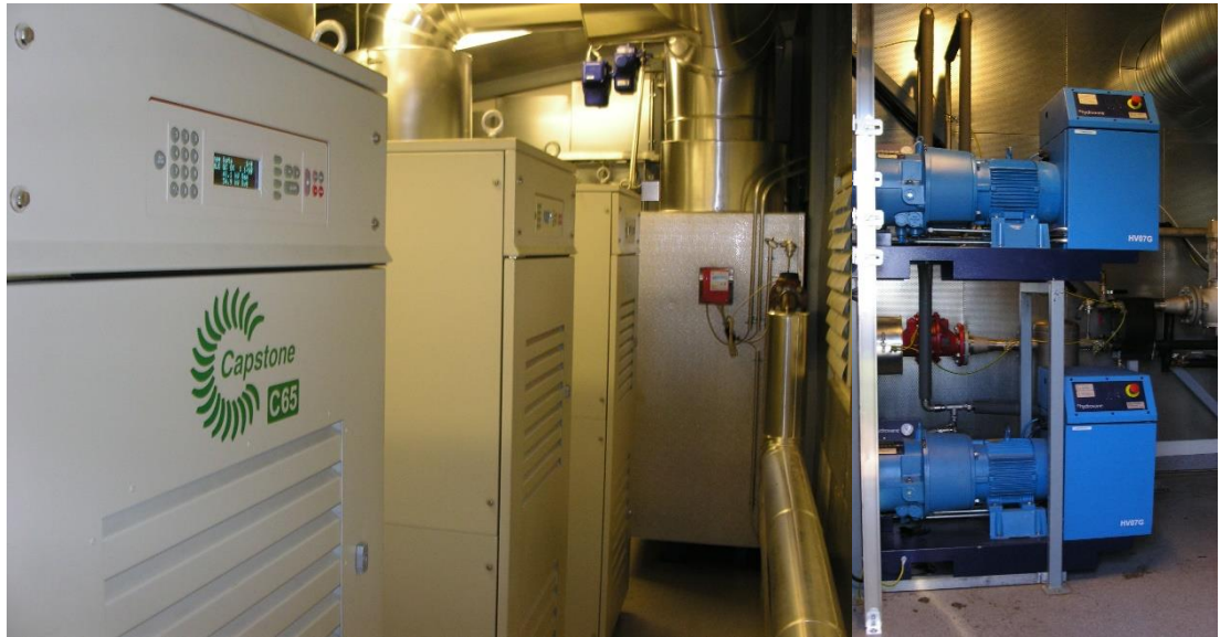
Kuva 10. Sarlinin Capstone C65-mikroturbiineja ja samaan laitokseen kuuluvia kompressoreita.
