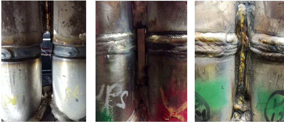
Kuva 10. Vasemmalla höyrystinputket ovat päittäisliitetty ja aukko on ikkunapalakoossa. Keskellä evä eli ikkunapala on asennettu paikoilleen. Oikealla evä on hitsattu ja membraaniseinämästä on saatu yhtenäinen.
