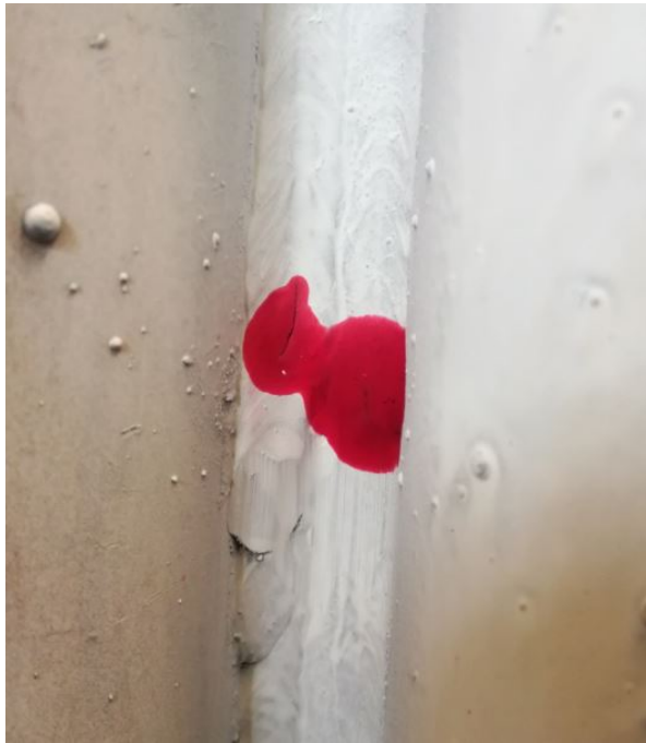
Kuva 36. Hitsauskoe 10. ei läpäissyt tunkeumanestetarkastelua.
