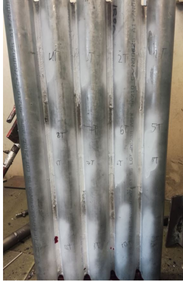
Kuva 34. Testipaneelin taustapuoli, mikä suihkutettiin valkoisella kehitteellä, josta hitsausvirheen tulokset on nähtävissä.
