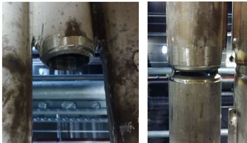
Kuva 11. Viistetty höyrystinputki ja höyrystinputkien sovittaminen linjaan, jonka jälkeen hitsataan paikoilleen silloitushitsaamalla.
