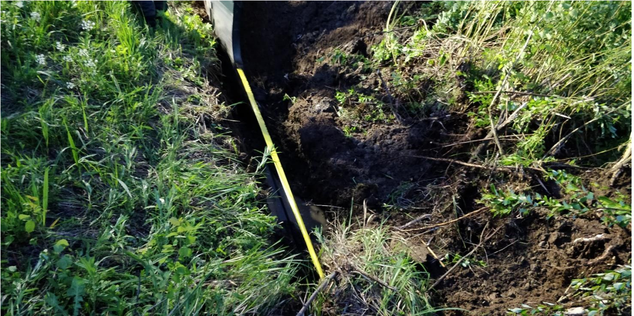
Kuva 2.7 Ratapenkkään auratusta kaapelista kertovan varoitusnauhan asennusta.
