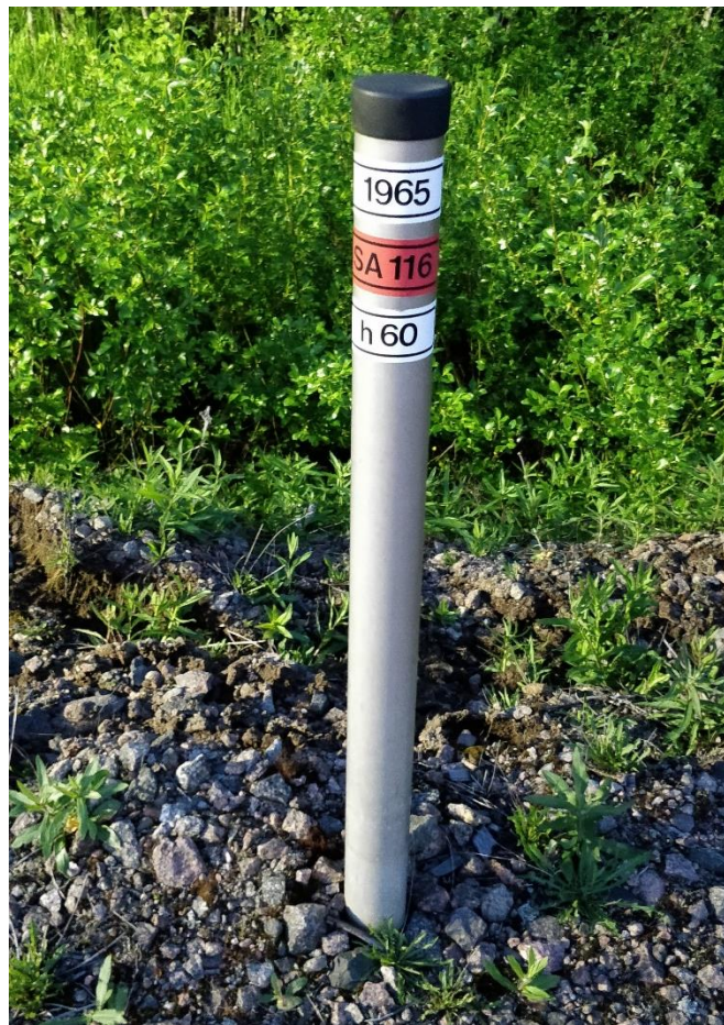
Kuva 2.6 Rata-alueella sijaitsevan kaapelin merkkipaalu.
