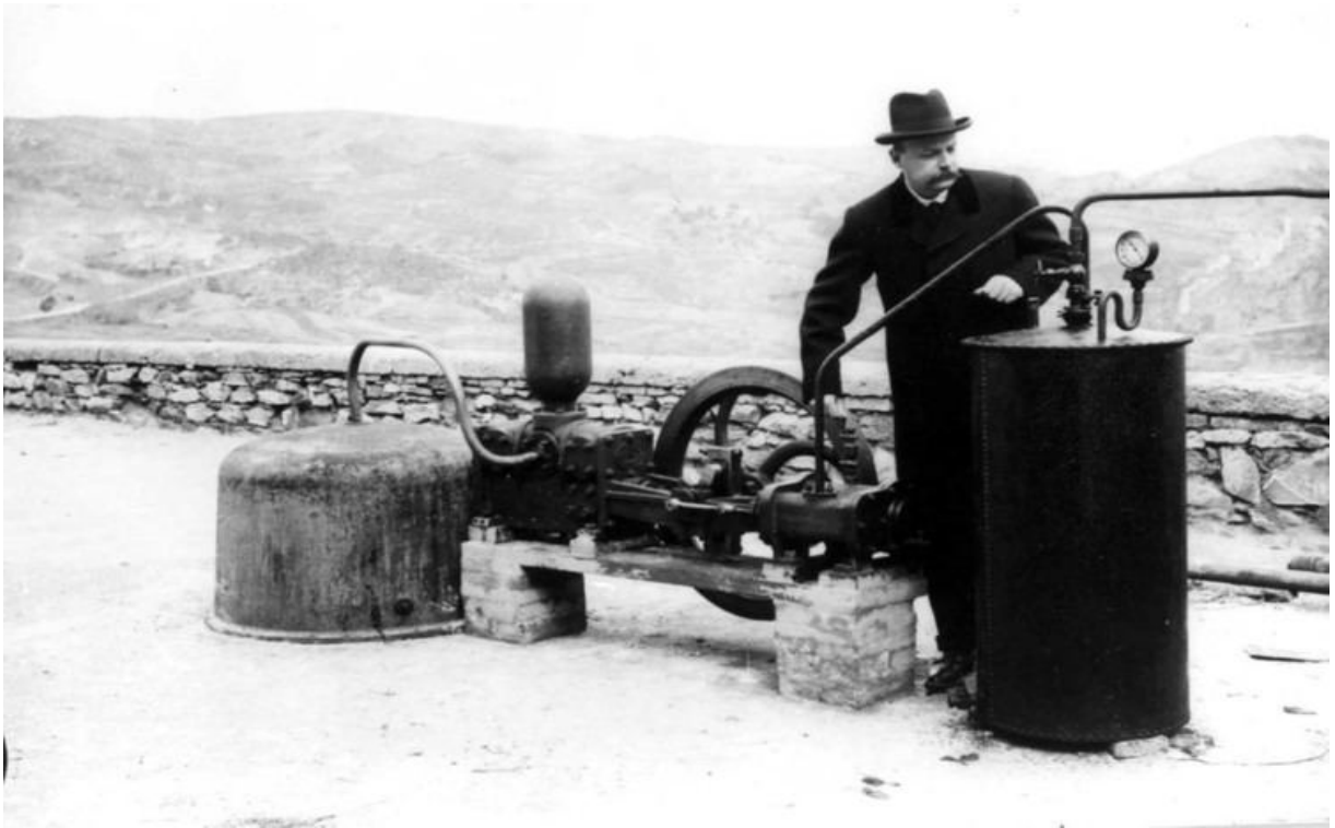
Kuva 6. Kuivahöyryvoimalaitos vuonna 1904 Italiassa, Lardellosa ( Alchetron )
