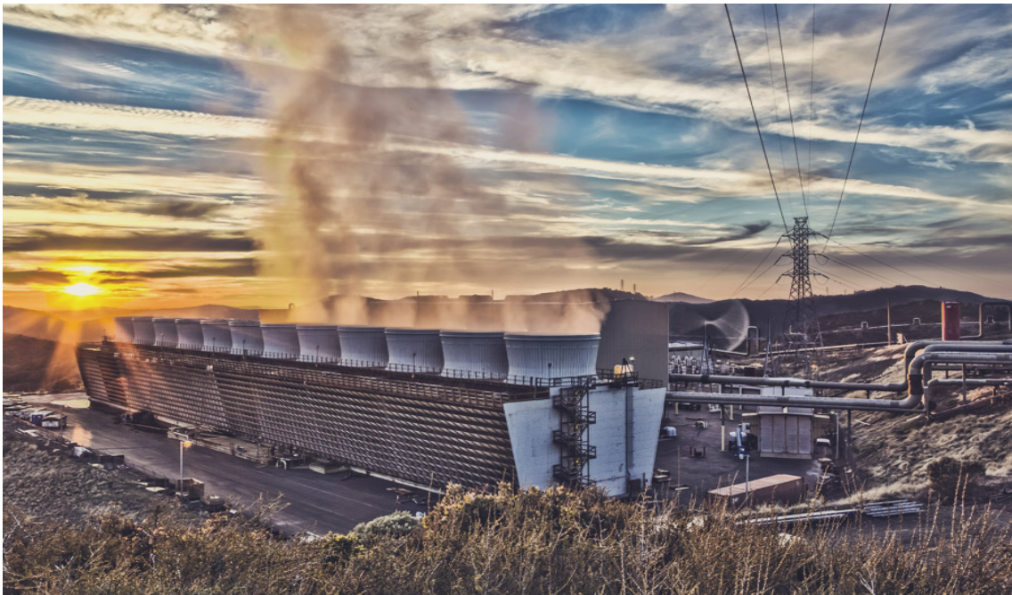
Kuva 7. Kuivahöyryvoimalaitos Yhdysvalloissa, The Geysers ( NCPA , 2015)
