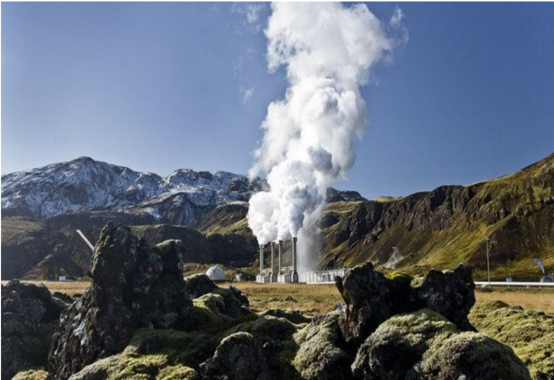
Kuva 9. Flash steam -voimalaitos Nesjavellirissä, Islannissa (Vimeo, 2010)
