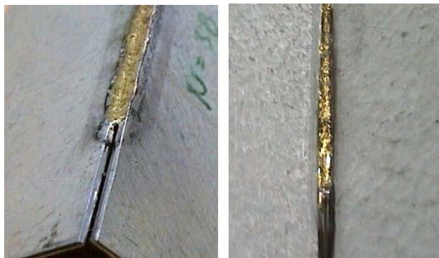
Kuvat 37 ja 38. Sinkityn ohutlevyn kaarijuotto. Kuva 37 yläpuolelta ja kuva 38 alapuolelta.
