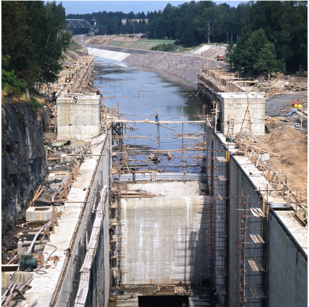
Kuva 8. Mälkiän kanavasulun rakennustyöt (Uusi-Honko Matti, k 1966-1967)
