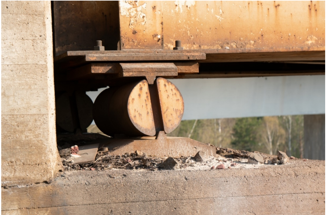
Kuva 22. Rullalaakerit Saimaan kanavan ratasillan Lauritsalan puoleisella maatuella (Kaira Tuomas k, 26.4.2019)
