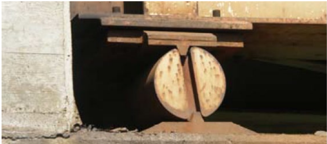
Kuva 36. Maatuen 1 liikkuva laakeri, ote Värähtelyraportin kuvasta 32. (Liikennevirasto 2011c)
