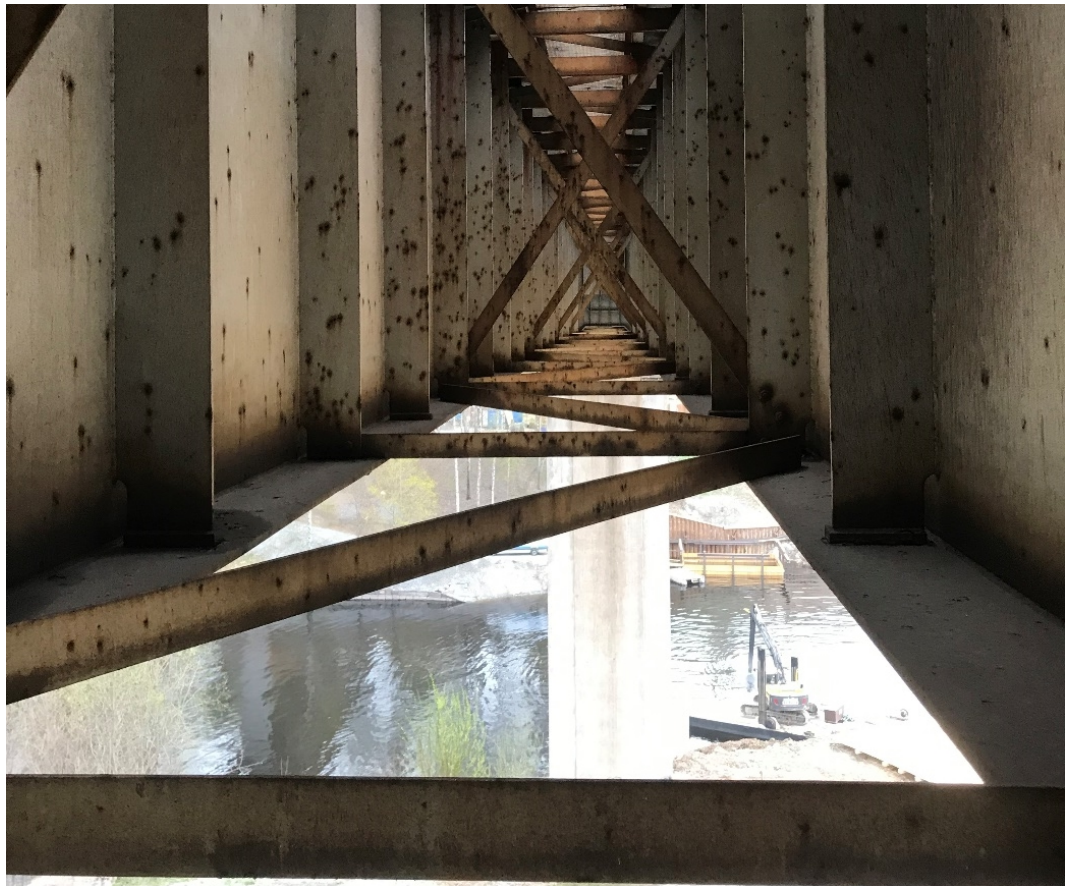
Kuva 17. Teräksinen jatkuva levypalkkisilta rakenteen sisältä kuvattuna (k, 2.5.2015)
