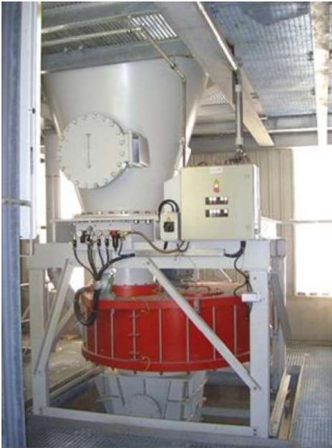
Kuva 4.2 Gravimetrinen polttoaineen massavirtamittaus. (Valmet 2014, 9)
