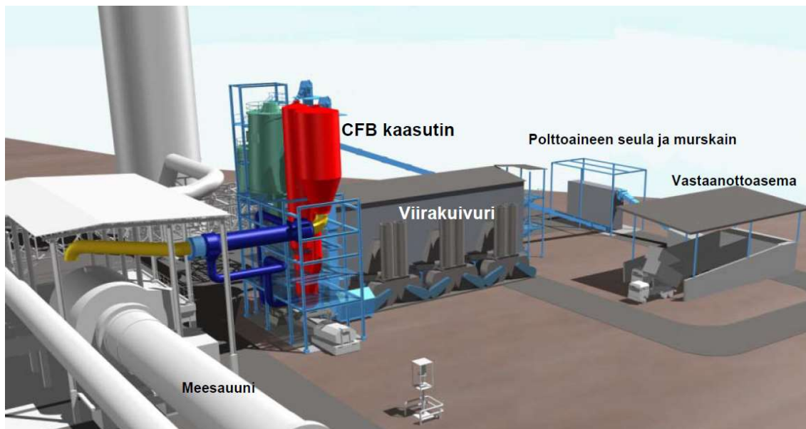
Kuva 5.5 Meesauuniin integroitu kierto- ja kaasutuslaitteisto. (Andritz 2010, 15)
