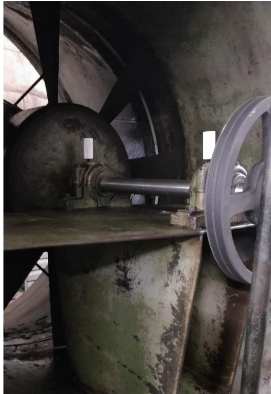
Kuva 1. Antureita asennettuna maan alaiseen puhaltimeen.
