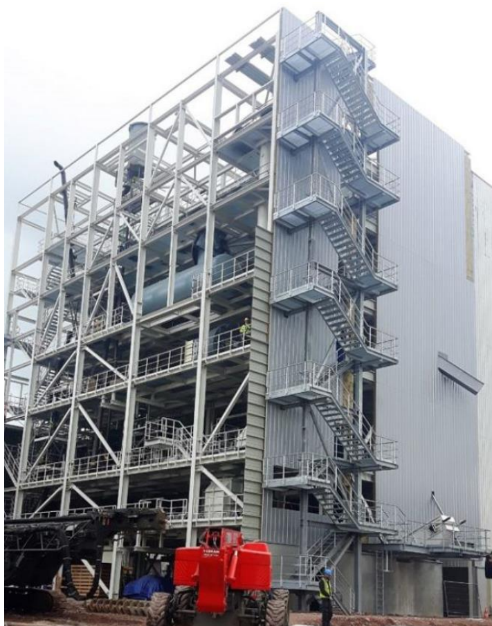
Kuva 5 Kattilarakennuksen teräsrakenne
