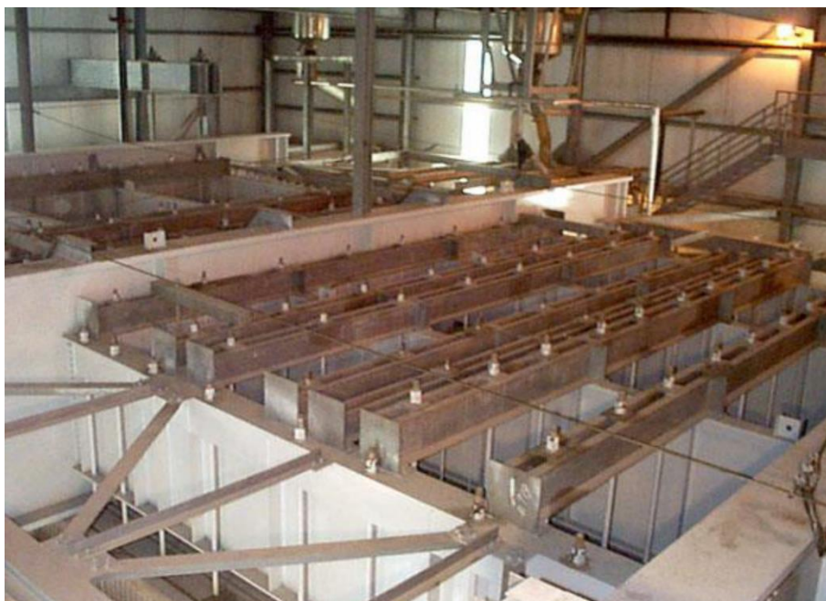
Kuva 6 Ripustetun kattilan rakenne (Vakkilainen, 2012, 14-3)
