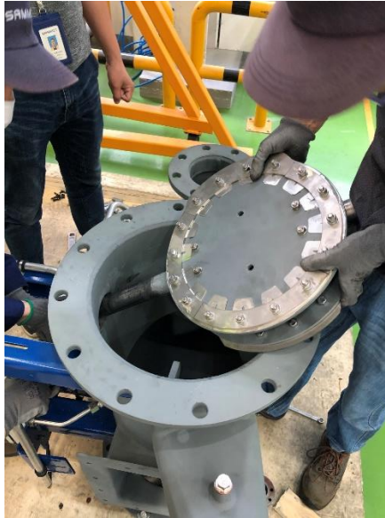
Kuva 48. Lapalevykokoonpanon asennus 3-tiepellin runkoon.
