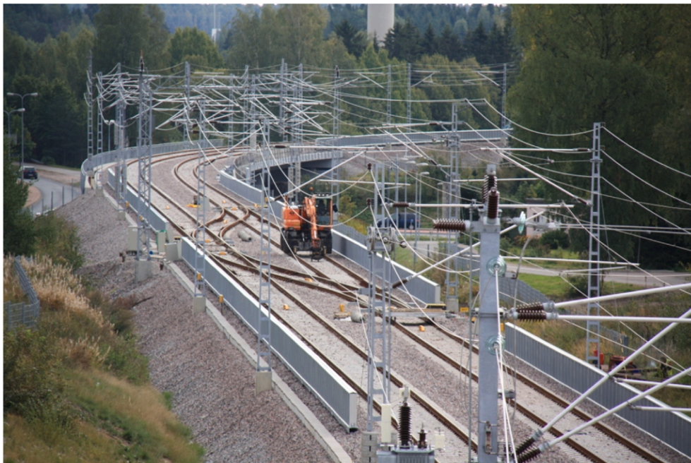
Fig. 1. Low-height noise barrier in Finland (Liikennevirasto, 2017).
