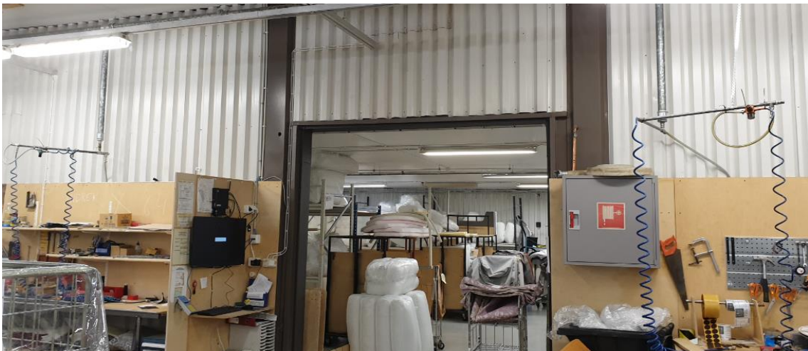
Kuva 20. Ulkoseiniä on laajennuksien yhteydessä jätetty tuotantotiloissa väliseiniksi. Kuva verhoonon tiloista kuvattuna.
