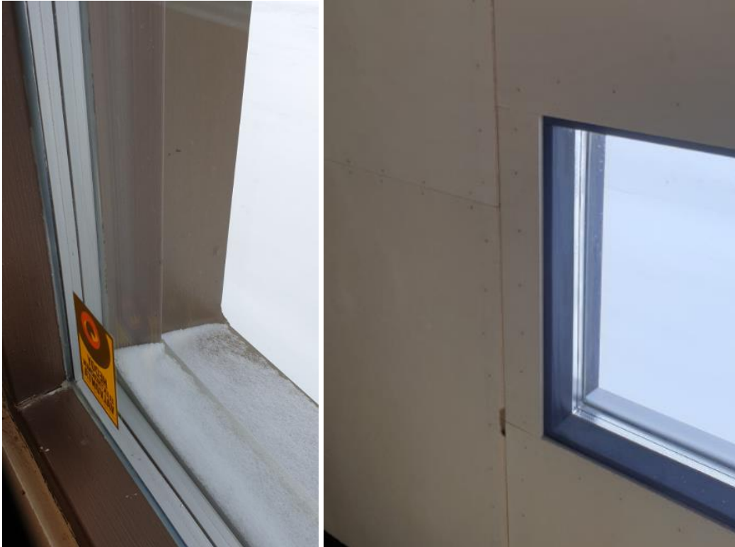
Kuva 19. Ikkunat ovat pääsääntöisesti kolmelevyisiä. Ulkoseinän sisälevytys on kipsilevyä useassa sisäseinässä.
