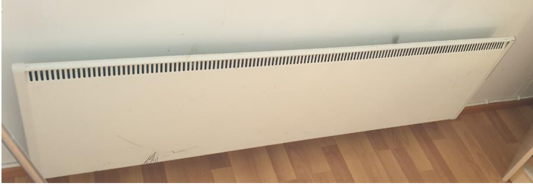
Kuva 22. Toimistotiloissa seinällä oleva sähköinen patteri.
