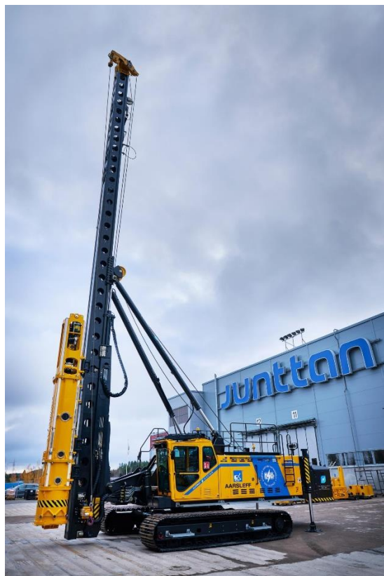
Kuva 1. Junttan PMx2e sähkökäyttöinen lyöntipaalutus kone. (Junttan 2021)
