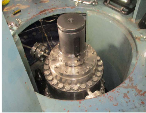
Kuva 25. Näkymä tiivistepesästä kasattuna moottorinvaihdon yhteydessä tehtävässä linjauksessa (Leppänen 2022).
