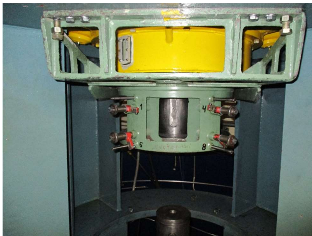
Kuva 11. STENMULLER moottorin linjauslaite. Kuva on otettu Loviisan vuosihuollossa 2021.
