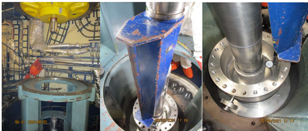
Kuva 10. Pumppuhuollossa suoritettava linjaus nykymenetelmällä. Kuvat on otettu Loviisan vuosihuollossa 2021.
