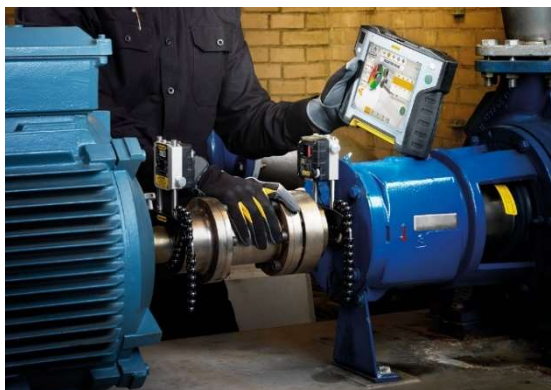
Kuva 5. Pumpun ja moottorin vaakatasoon linjaus laserlaitteella (YTM-Industrial b).
