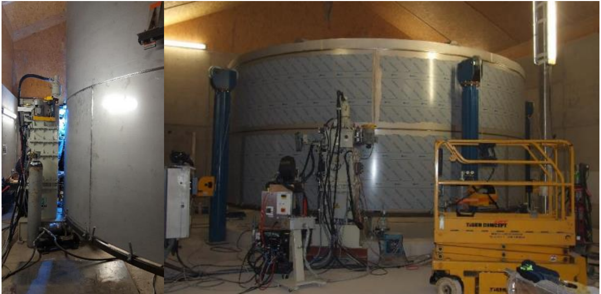
Kuva 9. EWM forceTIG: säiliön hitsaus (mukaiillen: Hietanen 2022a).
