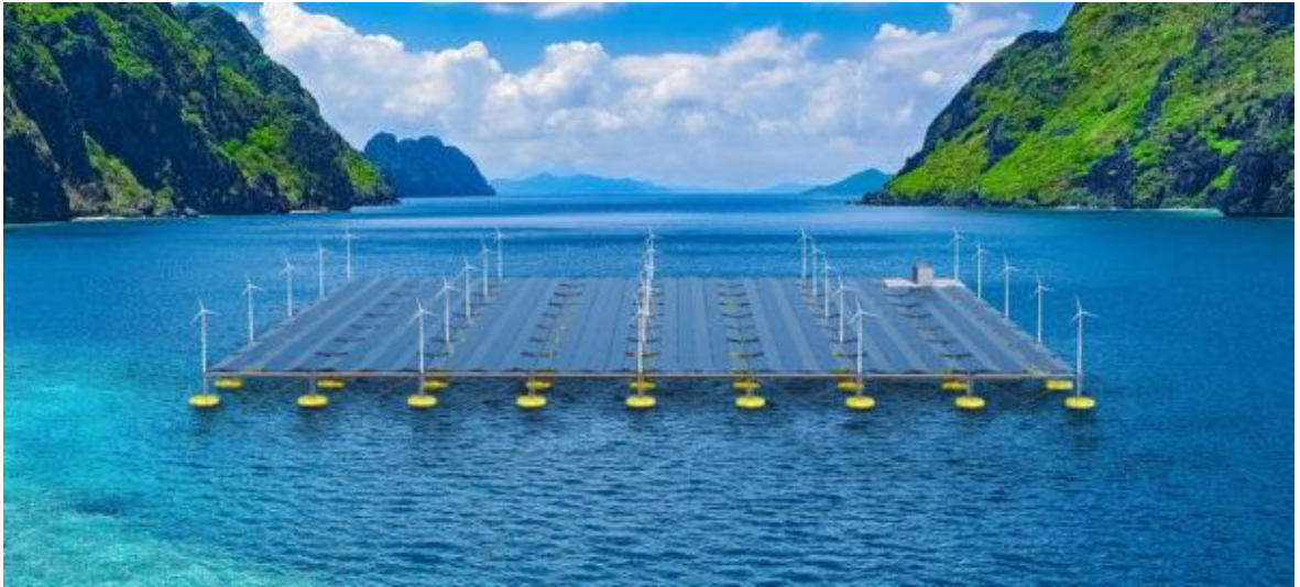
Kuva 9. Vedessä kelluva merihybridialusta, jolla voidaan yhdistää aurinko-, tuuli- ja aaltoenergia. (PV magazine 2021).
