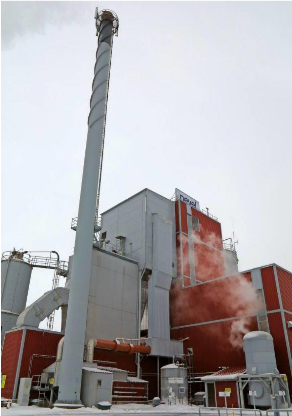
Kuva 5. Lieksan voimalaitos (Nevel, 2022)
