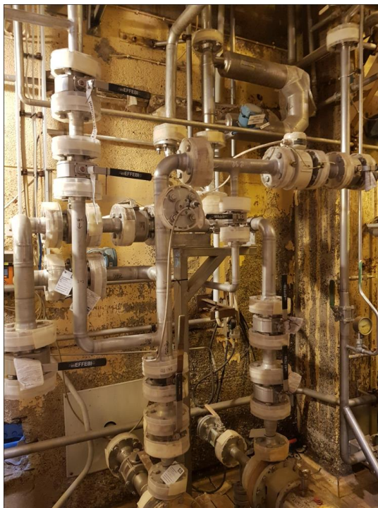
Kuva 1. Typpihapon siirtoputkisto
