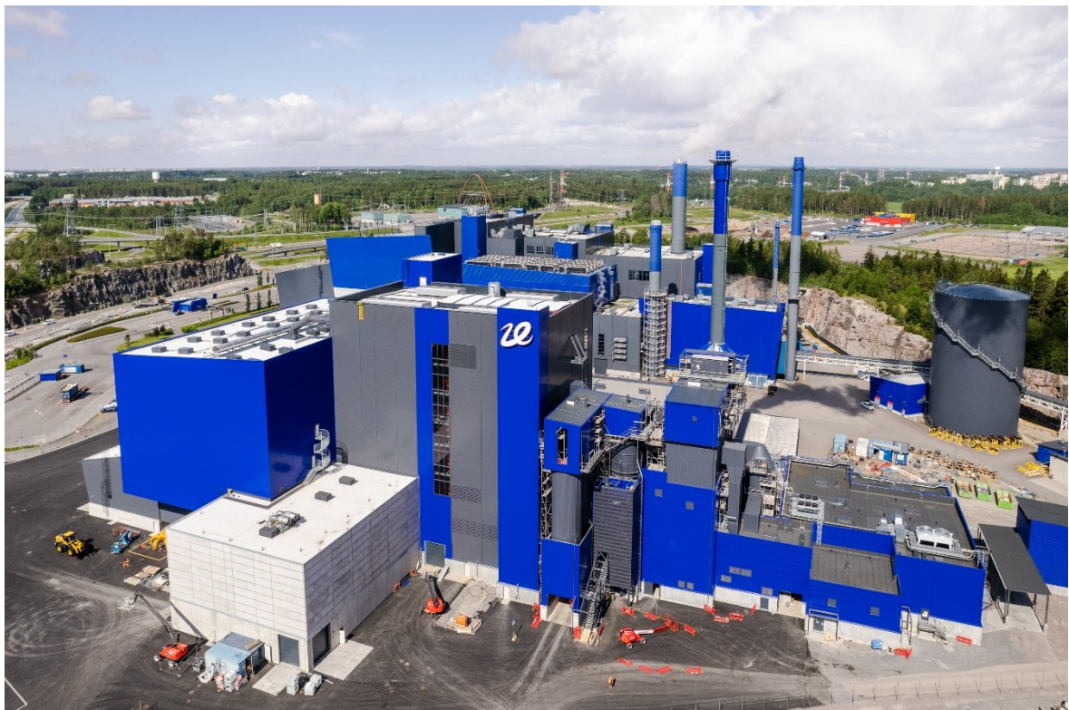
Kuva 4. Vantaan Energian jätevoimala. (Lähde: Vantaan Energia Oy, 2022c)
