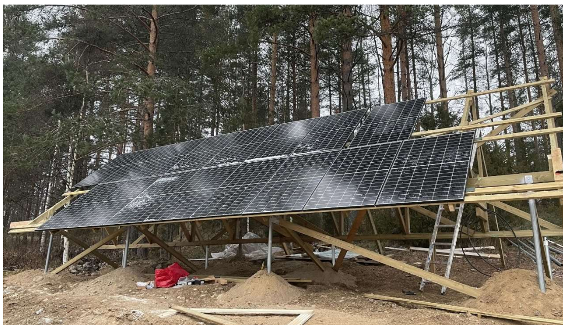
Kuva 9. Asennusvaiheessa oleva maa-asennettu 7,6 kWp aurinkosähköjärjestelmä vapaa-ajan asunnon tontille
