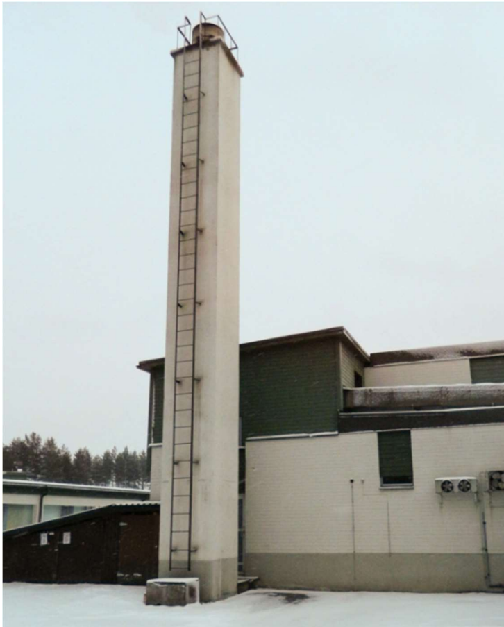
Kuva 5. Keskuskoululla sijaitseva lämpölaite (Keskuskoulu) /15/
