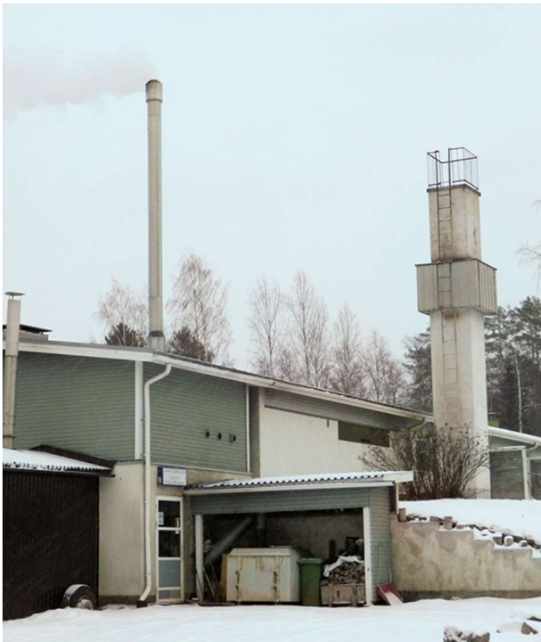
Kuva 4. Vilkaharjunttiellä sijaitseva lämpölaitos (Vilkaharjunttie) /15/
