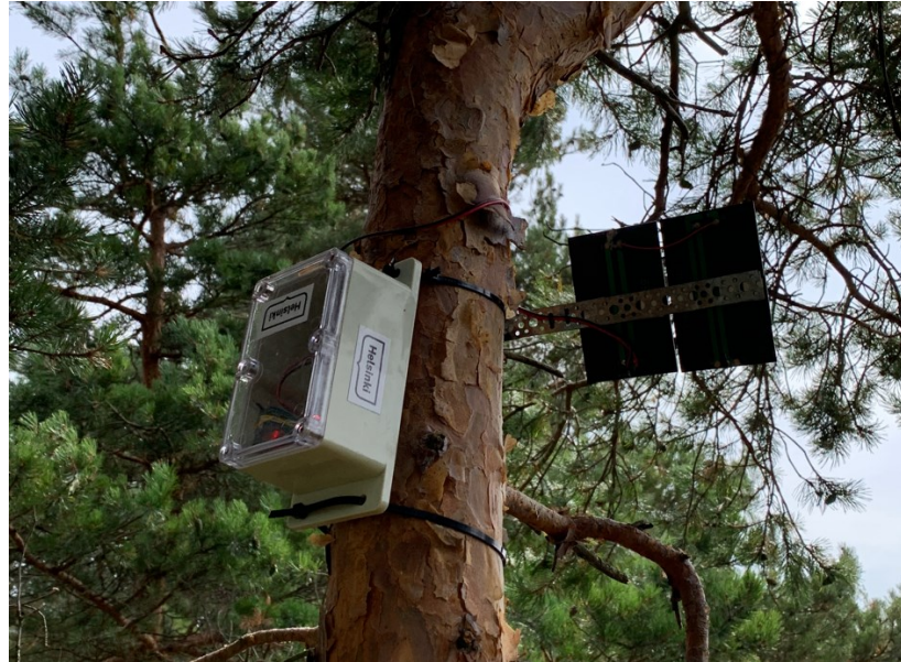
Kuva 30. Mittauslaite mäntyyn asennettuna.
