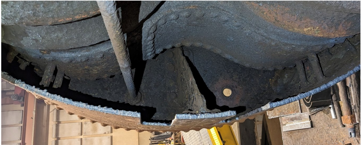
Kuva 13. Kattilan takaosassa sijaitseva vinotuki.
