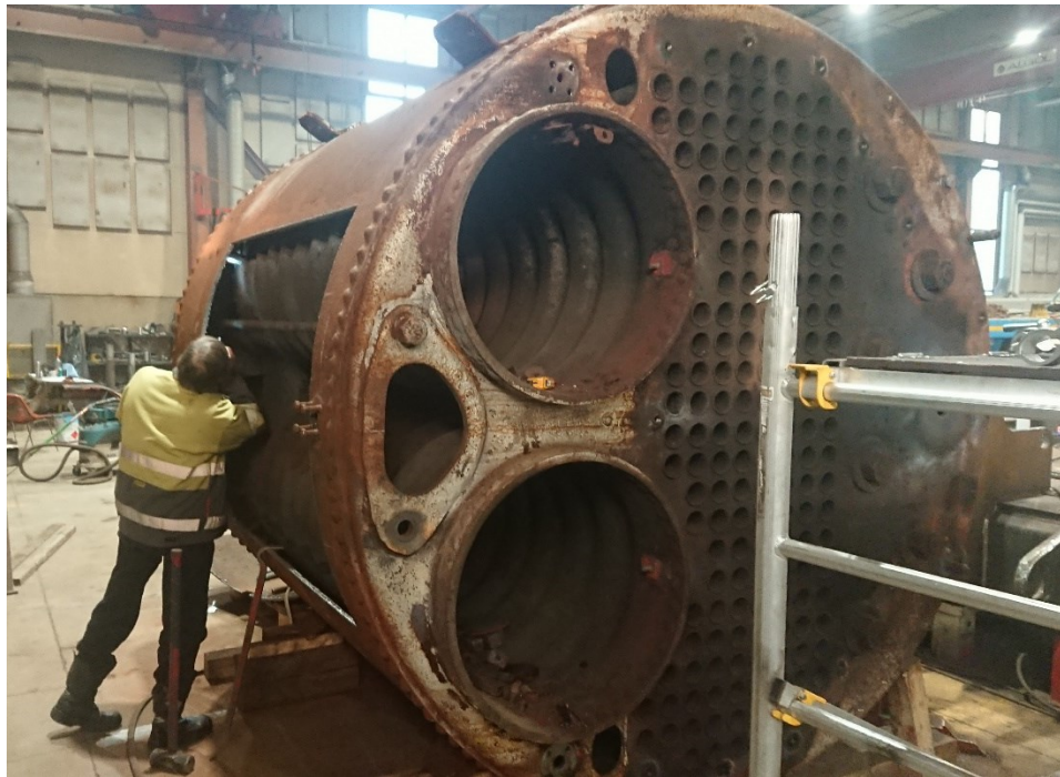
Kuva 10. Kattila korjaustyön suorittavan yrityksen tiloissa. Kattila on käännetty kyljelleen, ja sen pohjasta on leikattu lopullista korjattavaa aluetta pienempi pala pois.
