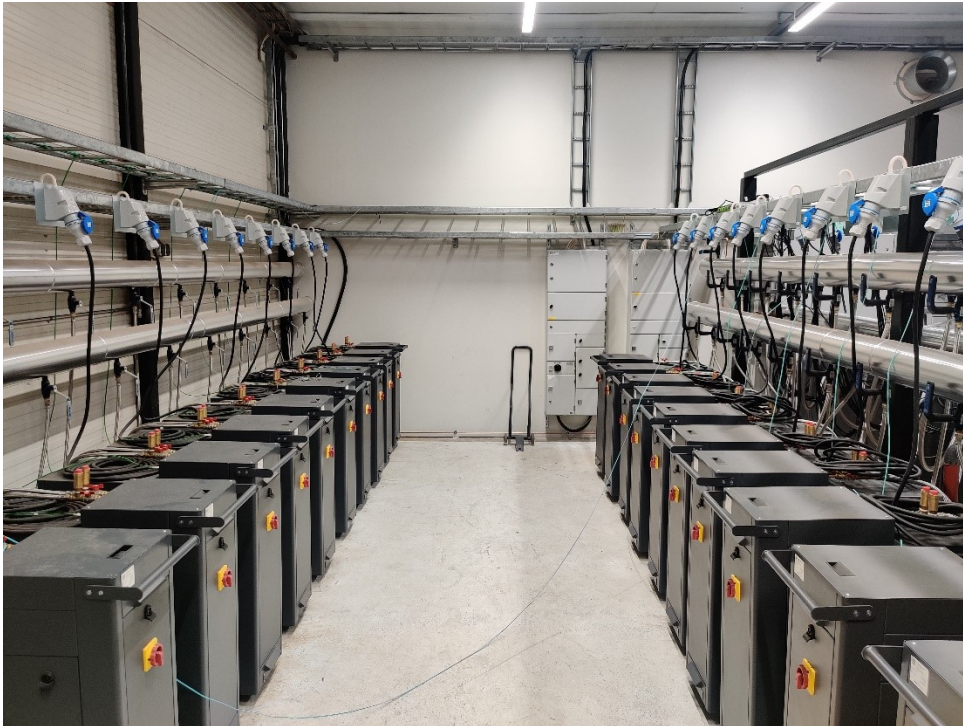
Kuva 17. Vatajankoski Oy:n datalämpöjärjestelmän serverit. (Petri Lähde)
