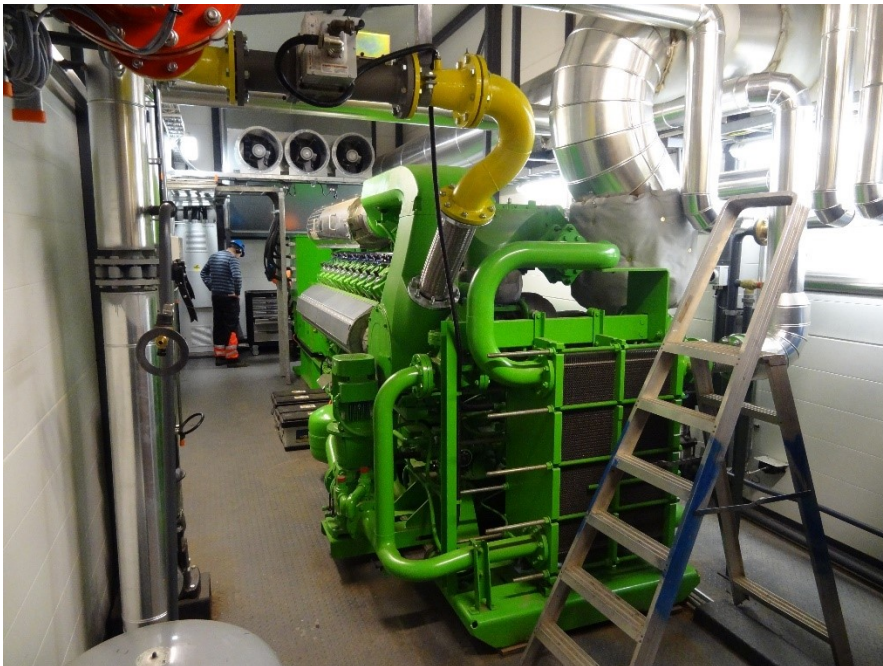
Kuva 10. Vatajankoski Oy:n Jenbacher kaasumoottori (Petri Lähde)
