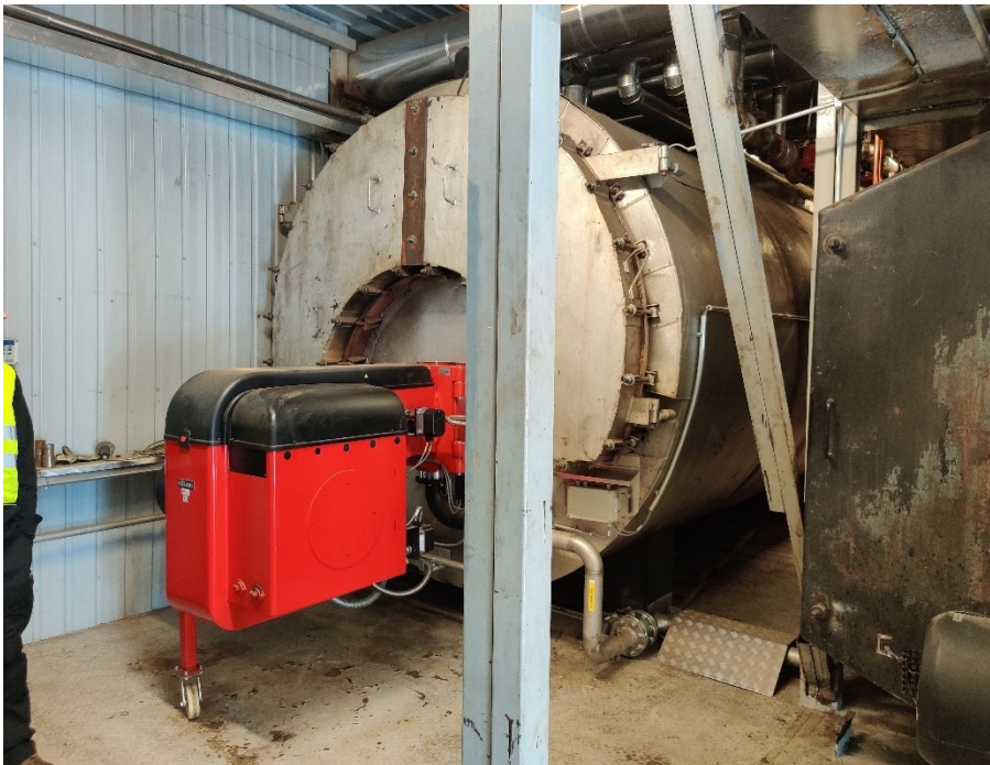
Kuva 11. Vatajankoski Oy:n 5MW kaasukattila (Petri Lähde)
