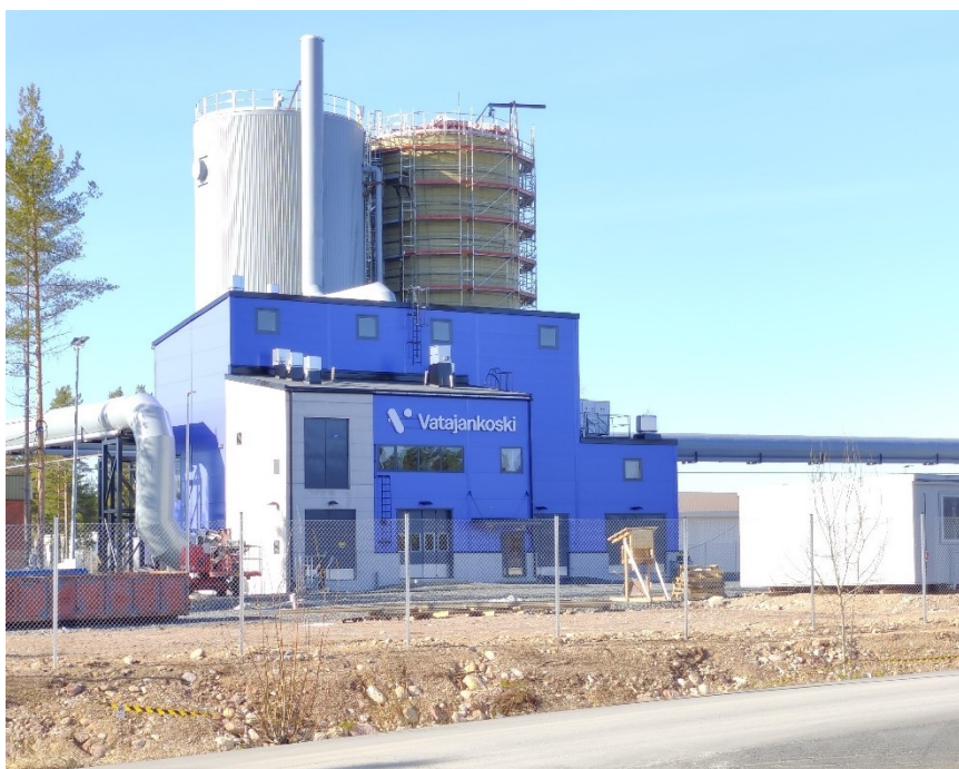
Kuva 12. Vatajankoski Oy:n kaukolämpöakut rakennusvaiheessa. (Petri Lähde)
