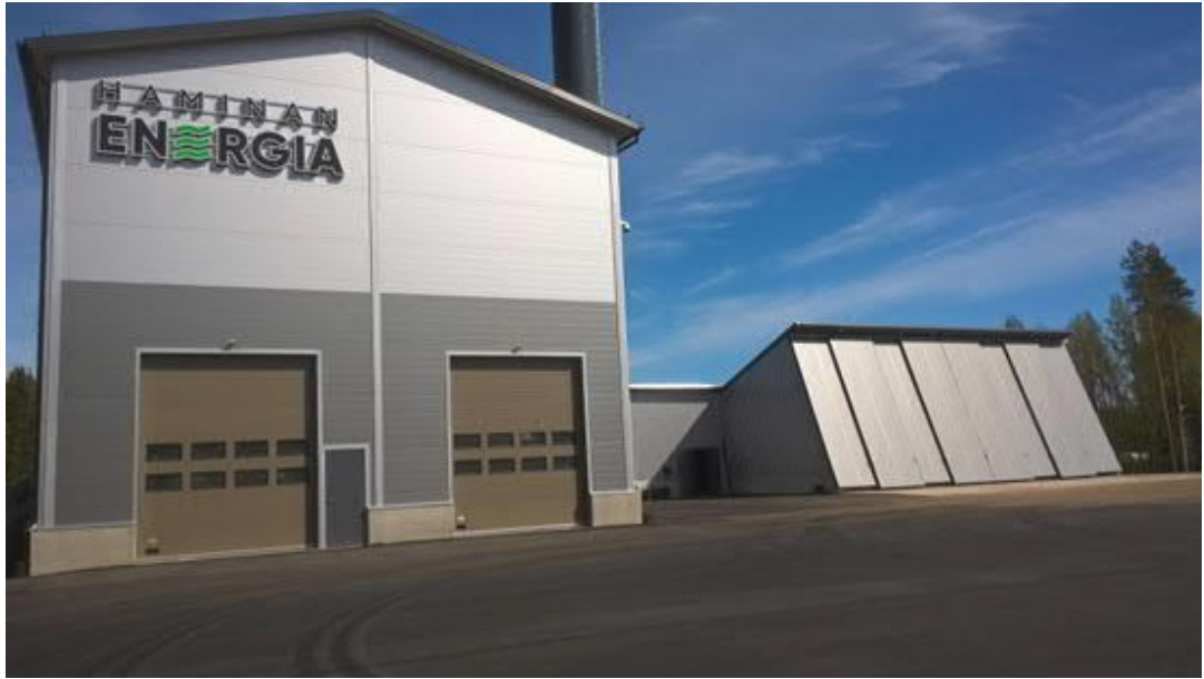
Kuva 4: Haminan Energian lämpökeskus
